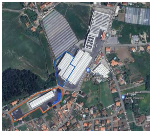
Figura 14 - Vista aérea das instalações MTG6.
