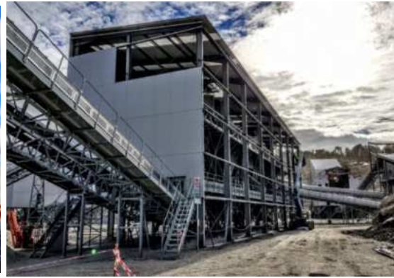
Figura 10 - Produção e montagem da estrutura metálica para a pedreira Gouvães.
