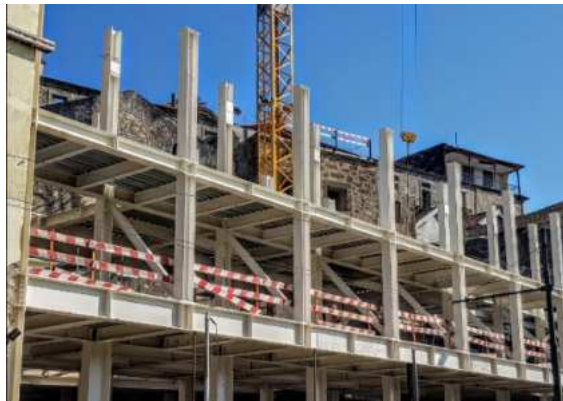
Figura 11 - Produção e montagem da estrutura metálica para o Hotel Neya, Porto.
