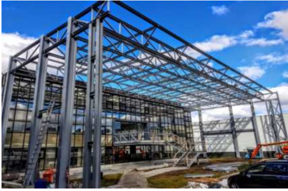
Figura 9 - Produção e montagem da fachada da empresa Endutex em Guimarães.
