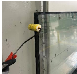
Figura 22 - Passagem do rolo para aperfeiçoar mastic .
