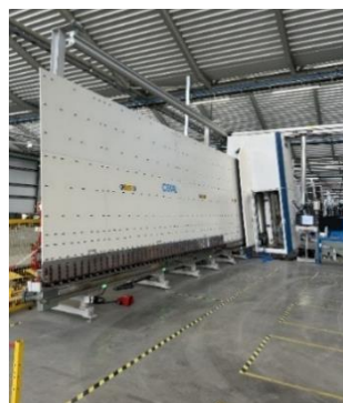
Figura 16 - Entrada da linha de montagem de vidro duplo e triplo.
