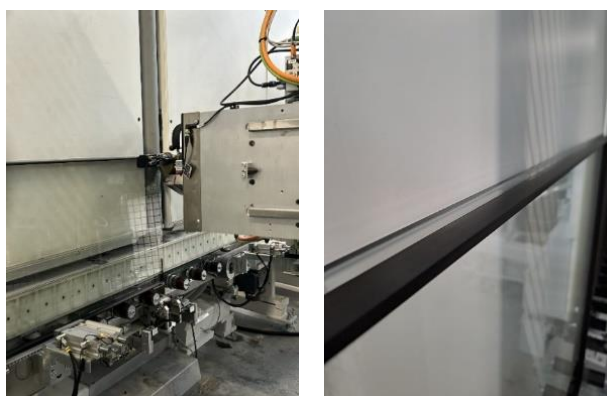
Figura 20 - Colocação do TS (1ª selagem).
