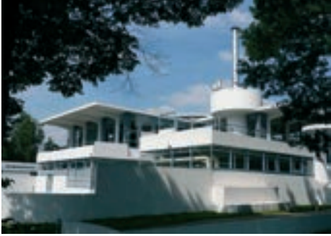
Ilustração 9 - Sanatório de Zonnerstraal após intervenção, s/d. ( http://commondatastorage.googleapis.com/static.panoramio.com/photos/original/3677908.jpg )
