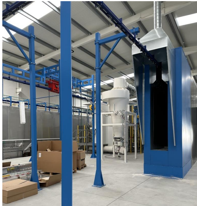
Figura 16: Instalação da linha de lacagem.
