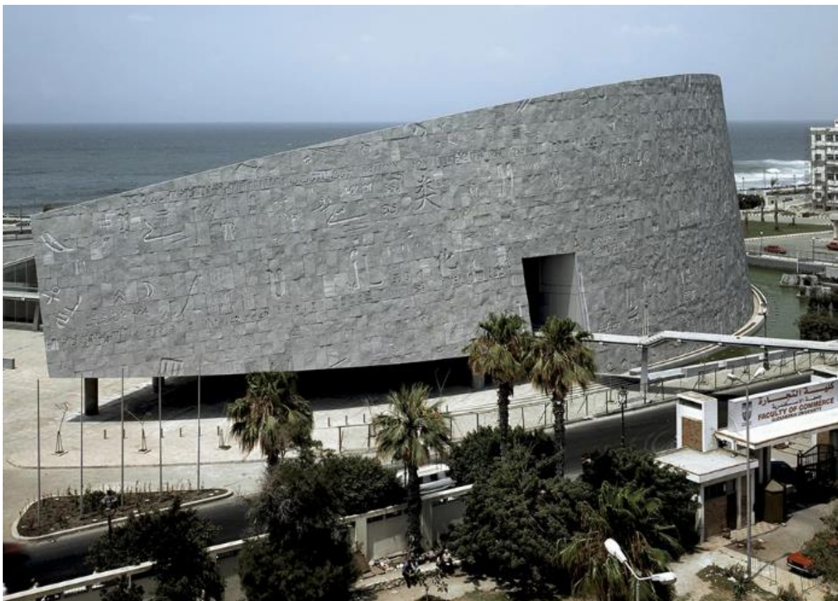
Figura 11 - Fachada da Biblioteca de Alexandria, Snøhetta, 2001, Alexandria, Egito
