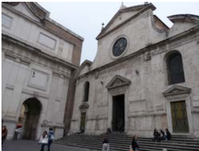
Ilustração 60 - Fachada da Igreja de Santa Maria del Popolo. (Ilustração nossa, 2013)
