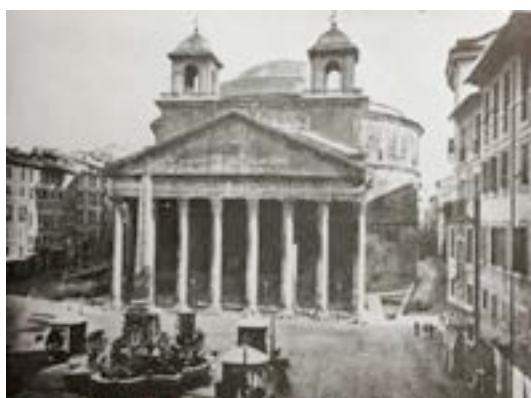
Ilustração 11 - O Panteão conservado entre as casas de Roma moderna, onde se vê os dois campanários, realizados por Bernini em 1600, que foram posteriormente demolidos para completar o isolamento do edifício antigo. (Benevolo, 2007, p. 159)
