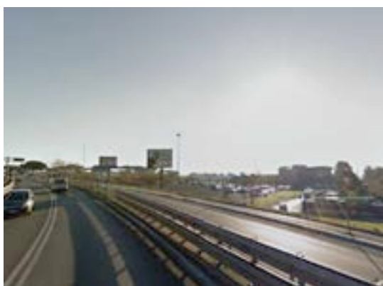
Ilustração 91 - Vista do local de intervenção. ([adaptação a partir de] Google Maps, 2013)
