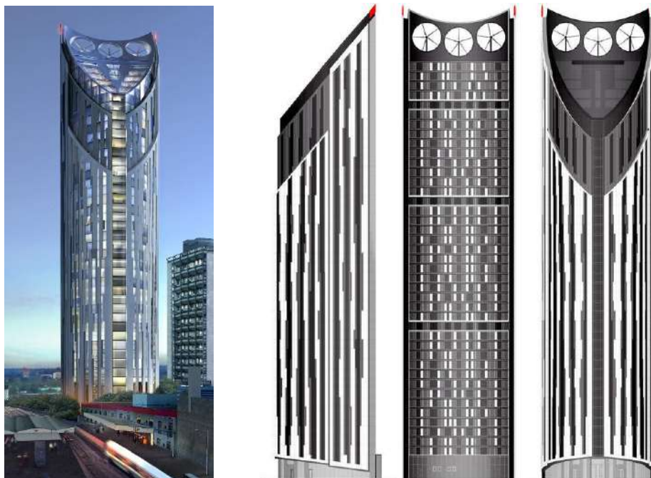
Figuras 122, 123 e 124 | Edifício Strata Tower , detalhes da construção dos geradores, vista a partir da rua e alçados com detalhes da estereotomia
