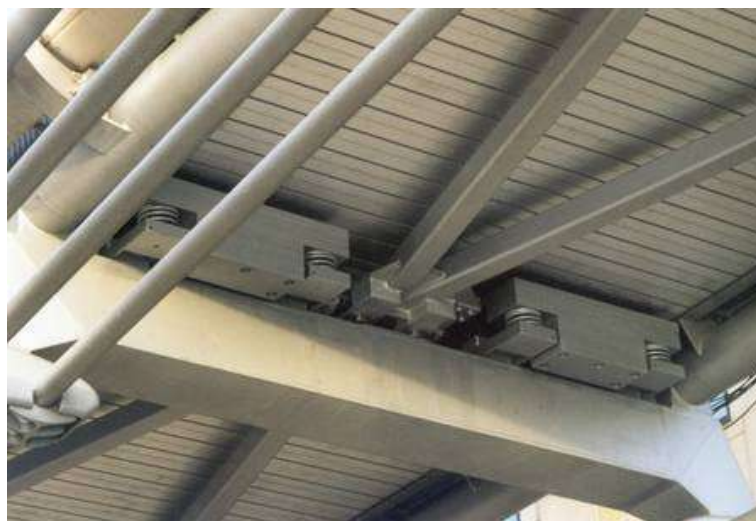
Figuras 105 e 106 | Ponte Millenium, vista lateral e localização dos TMD's
