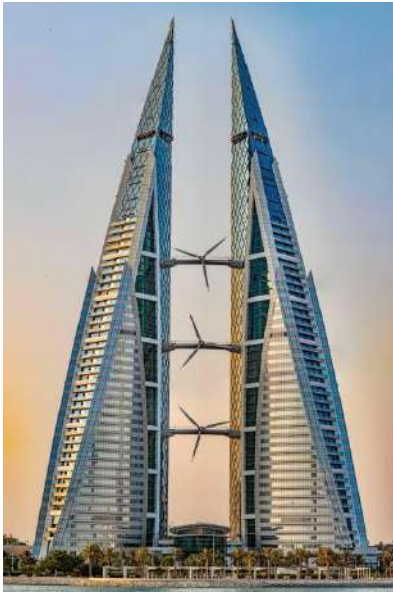
Figuras 120 e 121 | Edifício Bahrain WTC , alçado principal e secção do gerador mais elevado
