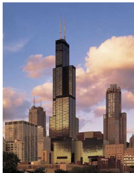
Figuras 072, 073 e 074 | Edifício Willis Tower, diagrama dos pisos, plantas e vista a partir do exterior
