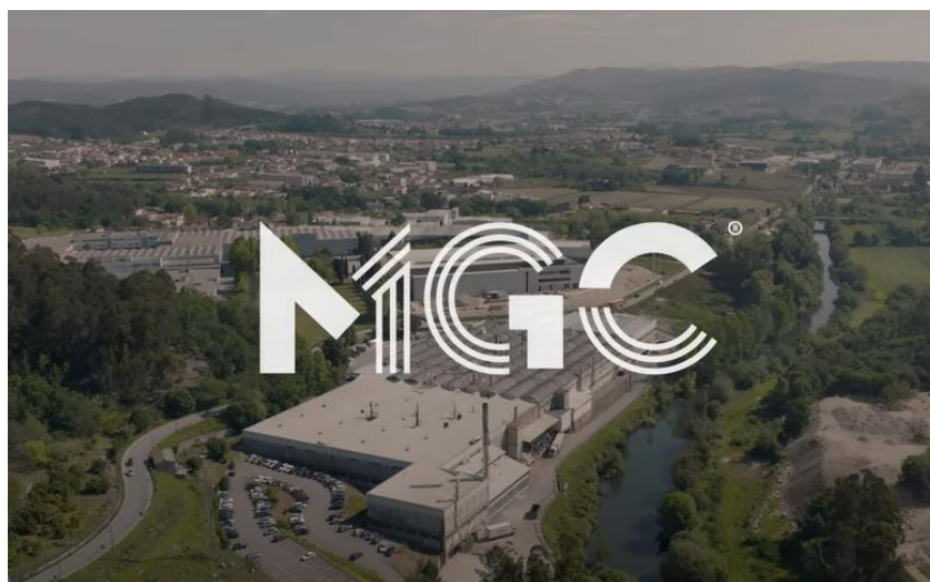
Figura 5 - Vista aérea panorâmica da empresa MGC – Acabamentos Têxteis.
