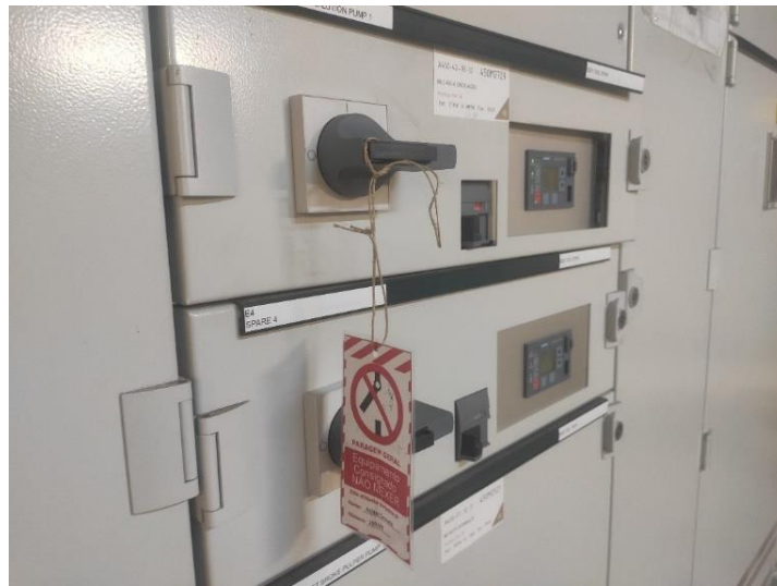
Figura 14 - Equipamento consignado eletricamente (Navigator Pulp Aveiro, 2023).
