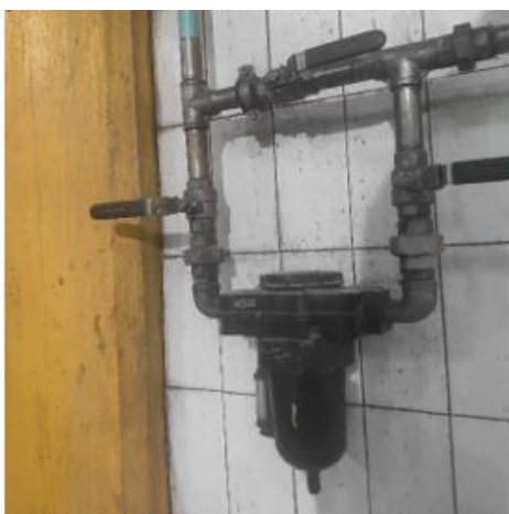
Figura 18 - Válvula manual de alimentação pneumática (Navigator Pulp Aveiro, 2023).
