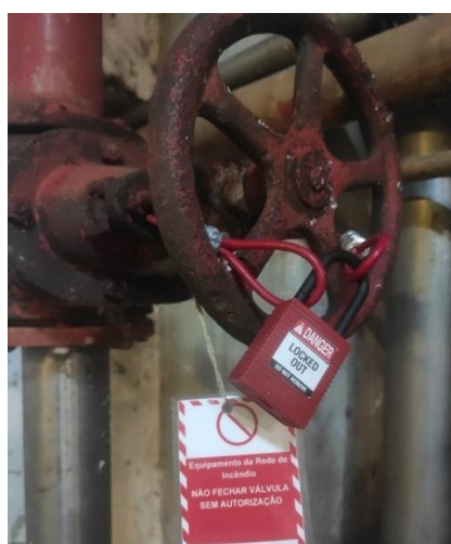
Figura 32 - Equipamento consignado localmente (Navigator Pulp Aveiro, 2023).
