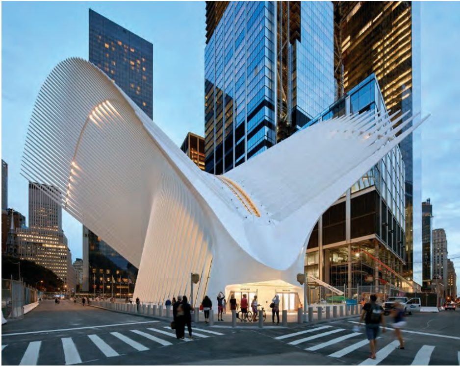
Santiago Calatrava – World Trade Center – Estação Path – Nova Iorque
