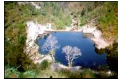
Figura 36 – Central minihídrica -Barragem de aproveitamento hidroeléctrico de Paredes.
