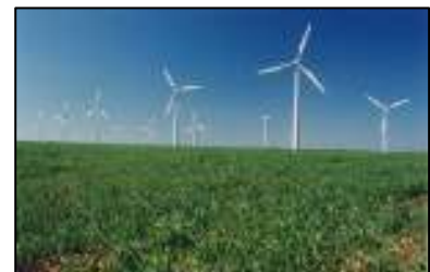
Figura 23 – Energia Eólica – sistema de eixo horizontal, parque eólico de Sines.
