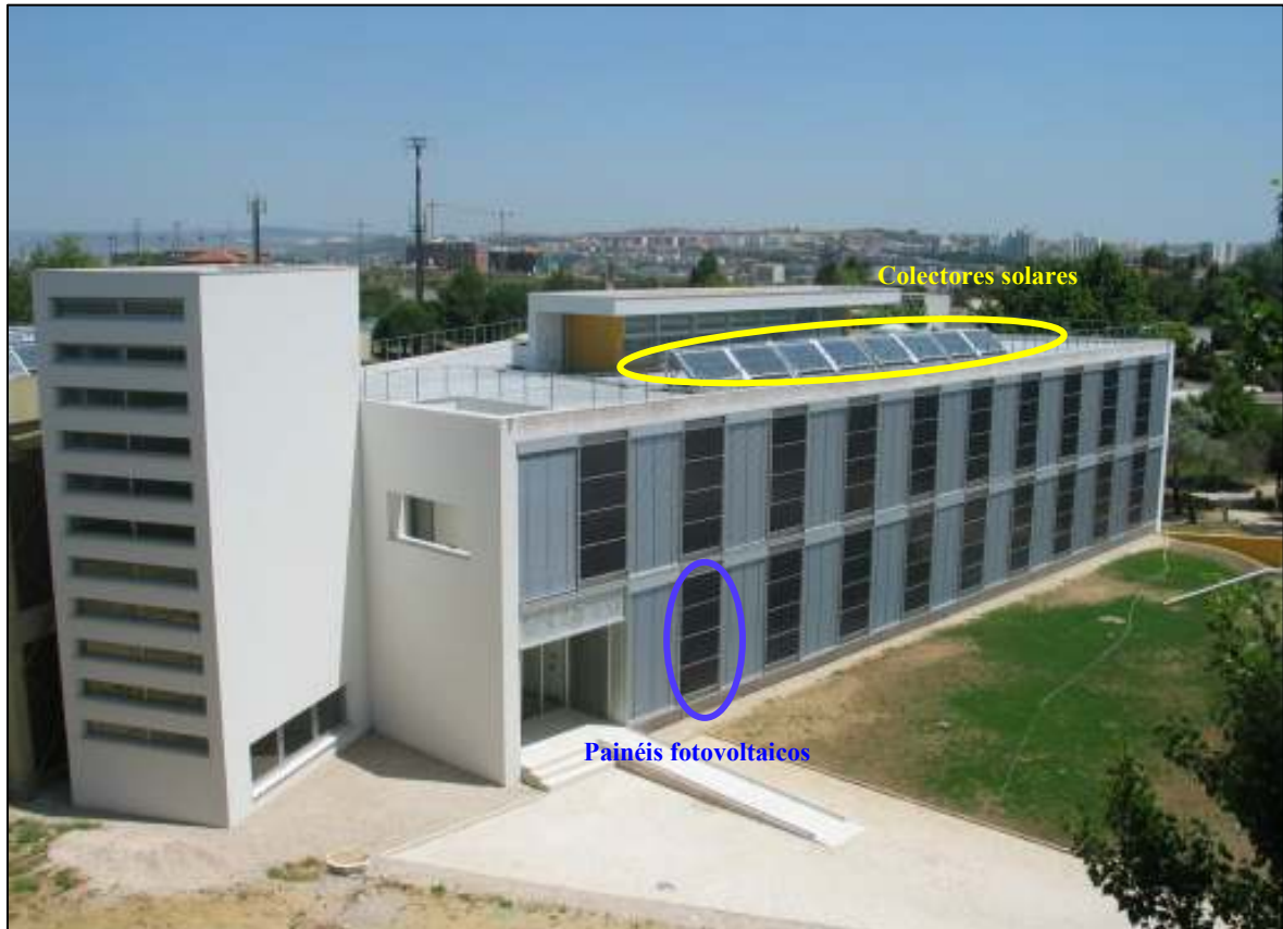
Figura 128 – Vista do Edifício Solar XXI do INETI – aplicação de colectores solares e painéis fotovoltaicos.
