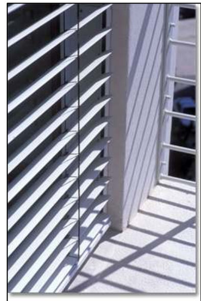
Figura 59 – Sombreamento Exterior, pormenor da fachada da Torre Sul no Parque das Nações, projecto da Arquitecta Livia Tirone, 2002 http://tironenunes.pt
