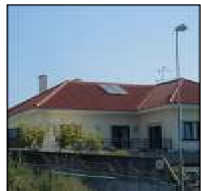
Figura 91 – Exemplo de boa integração arquitectónica de um campo de colectores num edifício. www.aguaquentesolar.com
