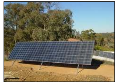
Figura 104 – Painel poli cristalino KYOCERA na REVEZ – SOLAR.
