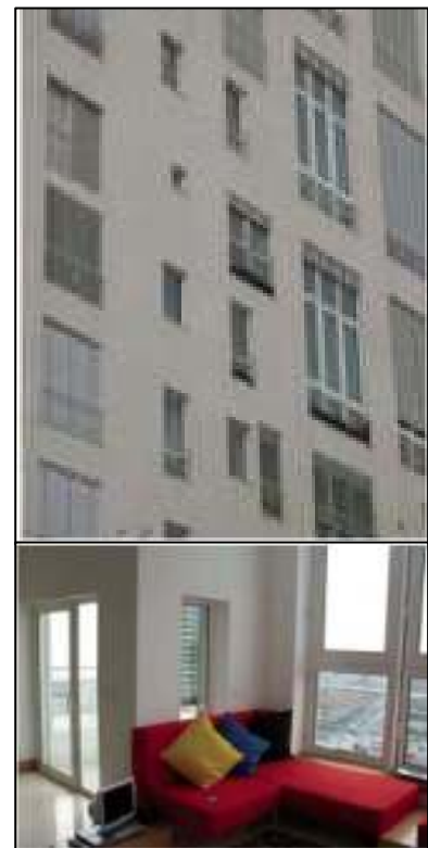
Figura 58 – Envidraçado com sombreamento exterior, pormenor da fachada da Torre Sul no Parque das Nações, projecto da Arquitecta Livia Tirone, 2002 http://tironenunes.pt
