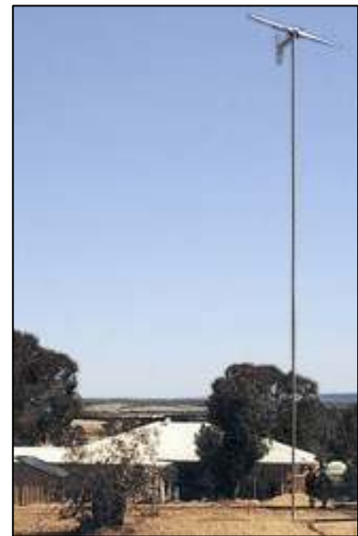
Figura 115 – Casa no Alentejo com integração de uma micro turbina eólica para produção de electricidade.
