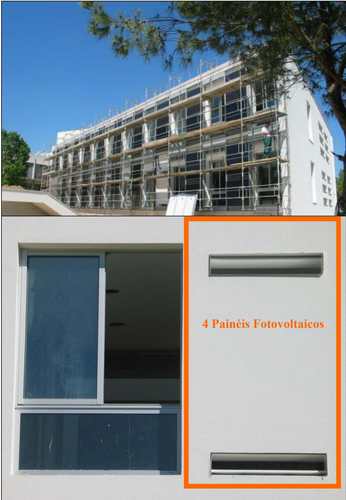
Figura 130 – Vista do Edifício Solar XXI do INETI – Fachada a Sul (instalação do sistema fotovoltaico); pormenor das aberturas criadas na fachada para aproveitamento do calor criado nos painéis fotovoltaicos.
