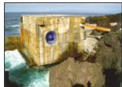
Figura 37 – Protótipo de aproveitamento da energia das ondas tipo coluna de água oscilante, Ilha do Pico, Açores
