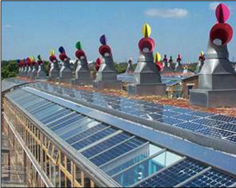
Figura 124 – BedZed – Cobertura com painéis fotovoltaicos.
