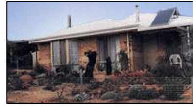
Figura 114 – Casa no Alentejo com integração de painéis fotovoltaicos para produção de electricidade.
