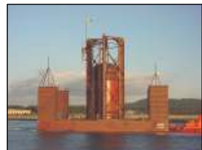
Figura 39 – Protótipo de aproveitamento da energia das marés AWS (Archimedes Wave Swing), Viana do Castelo
