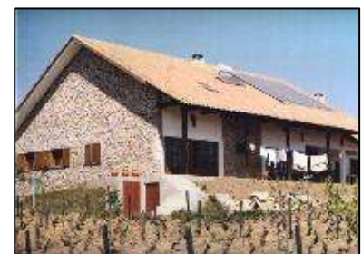
Figura 112 – A “Casa Solar” em Freixo de Espada à Cinta – painéis solares Térmicos.
