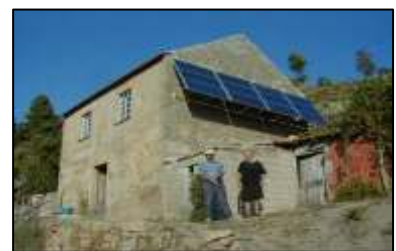
Figura 109 – Sistema de iluminação e TV em Moradia - Beira Alta.
