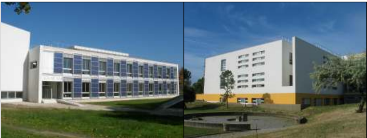
Figura 127 – Vista do Edifício Solar XXI do INETI – Fachada a Sul (com aplicação de painéis fotovoltaicos) e fachadas Nascente e Norte.
