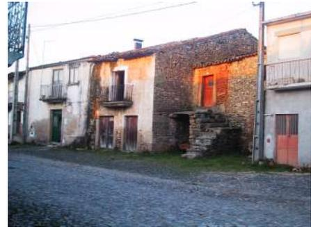
Fig. 55 - Sistema construtivo conhecido por tabique
