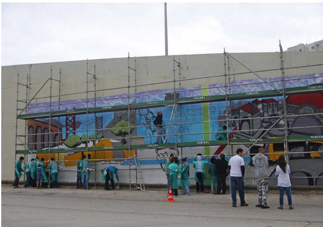
Ilustração 3 - Concretização da Pintura Mural na Sede da Carris. (Ilustração nossa)
