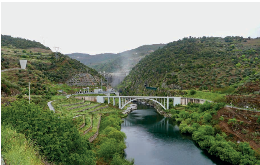
FIG. 4 Conjunto da Barragem de Foz Tua (Souto de Moura, central hidroeléctrica, reservatório de água, posto de observação e controlo, 2011-2018) e ponte de Edgar Cardoso, 1938. Fotografia de Maria João Moreira Soares, 2022.
