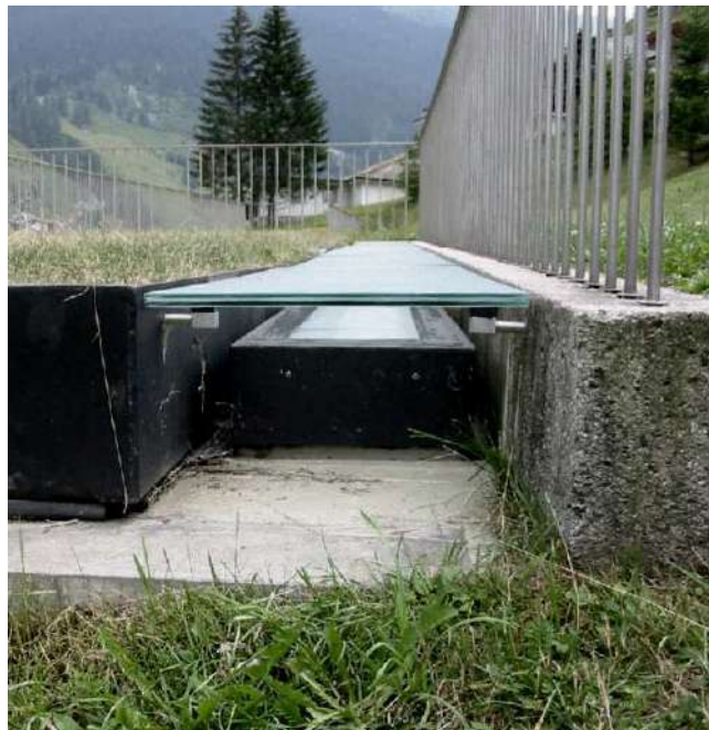
Figura 2.29: Fenda de iluminação da cobertura. Reproduzido de MYLONAKI, Natalia, [acedido a 31 de Agosto de 2021] disponível em http://www.nataliamylonaki.com/portfolio/projects/8-roof-detail-analysis?locale=en
