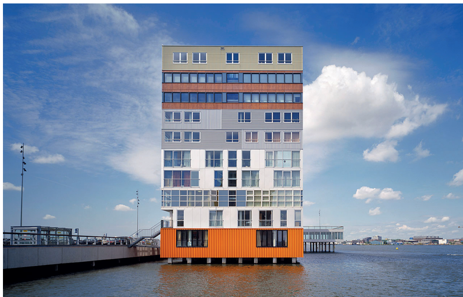
Ilustração 18 - Edifício Silodam, vista lateral, Amsterdão, Holanda. (MDRDV, 2003)
