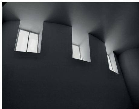
Ilustração 10. Três vãos na parede curva, a noroeste. (ilustração nossa, 2021)
