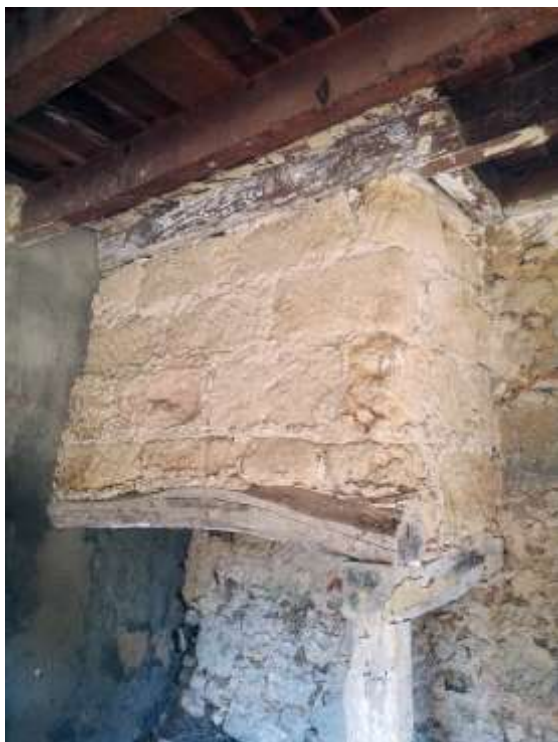
Ilustração 66 – Chaminé em tufo calcário e vigas de madeira na casa P2 . (Ilustração nossa, 2021)
