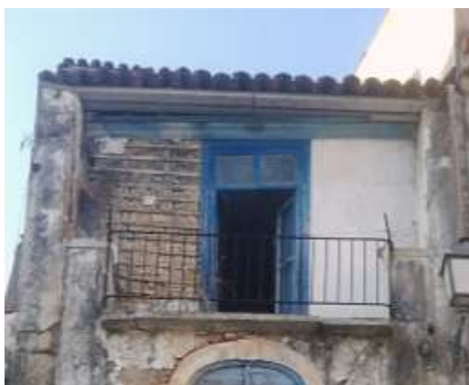
Ilustração 81 – «Sobradinho» com parede em tabique. (Ilustração nossa, 2021)
