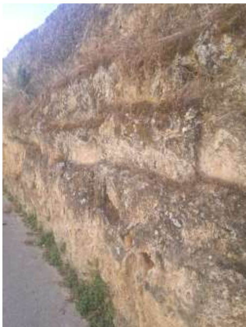
Ilustração 25 – Muro de tufo feito a partir da extração dos cantos em Torres Novas. (Ilustração nossa, 2021)
