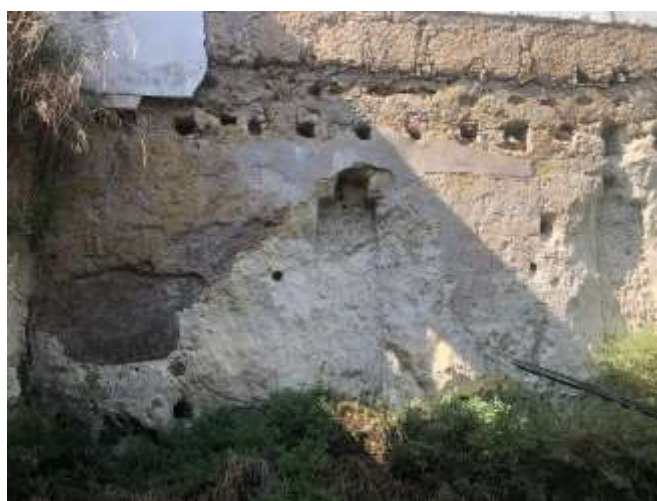
Ilustração 61 – Perfuração de tufo calcário para colocação de vigas. (Ilustração nossa, 2021)
