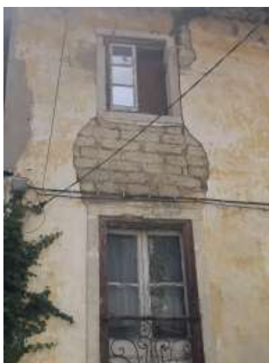
Ilustração 87 – Casa com tijolo de adobe na fachada principal. (Ilustração nossa, 2021)
