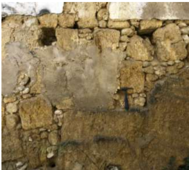
Ilustração 23 – Ruína de uma casa cuja fundação foi feita num canteiro de extração de tufo em Lapas. (Ilustração nossa, 2021)
