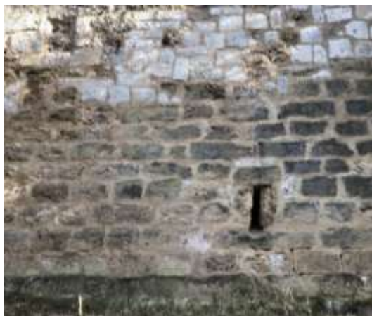
Ilustração 36 – Troço da muralha fernandina com intrusão de outras pedras calcárias (mais brancas) além do tufo. (Ilustração nossa, 2021)
