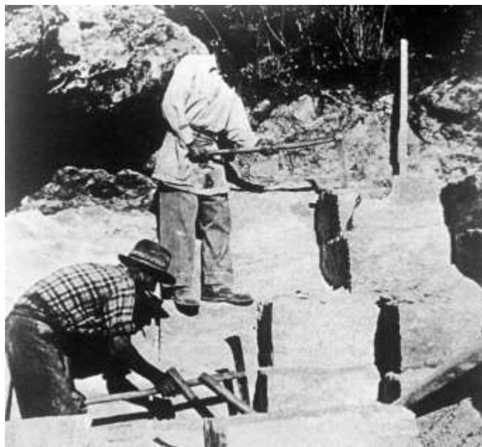
Ilustração 9 – Trabalhadores extraem o tufo calcário. ([Adaptado a partir de:] Pereira N., Freitas A. e Silva F., 2004, p. 59)
