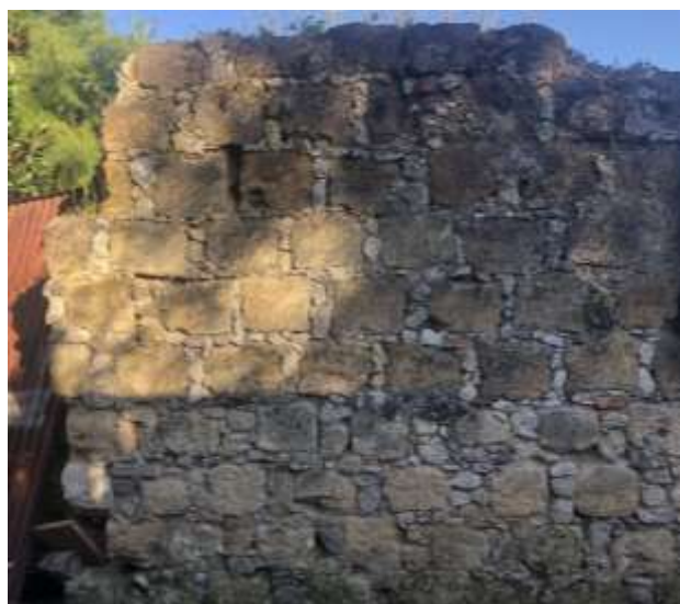
Ilustração 52 – Muro de tufo calcário aparente na atualidade. (Ilustração nossa, 2021)
