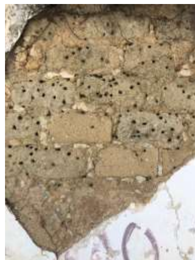
Ilustração 88 – Pormenor do «rendilhado» de pedra na alvenaria de adobe. (Ilustração nossa, 2021)
