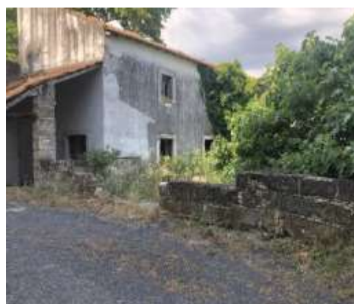
Ilustração 35 – Moinho abandonado nos dias de hoje, com muros de alvenaria de tufo calcário. (Ilustração nossa, 2021)
