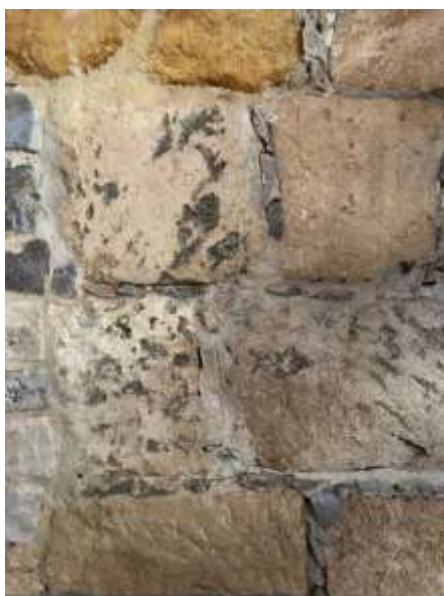
Ilustração 96 – Paredes de tufo calcário aparente com tratamento de verniz para proteção. (Ilustração nossa, 2021)
