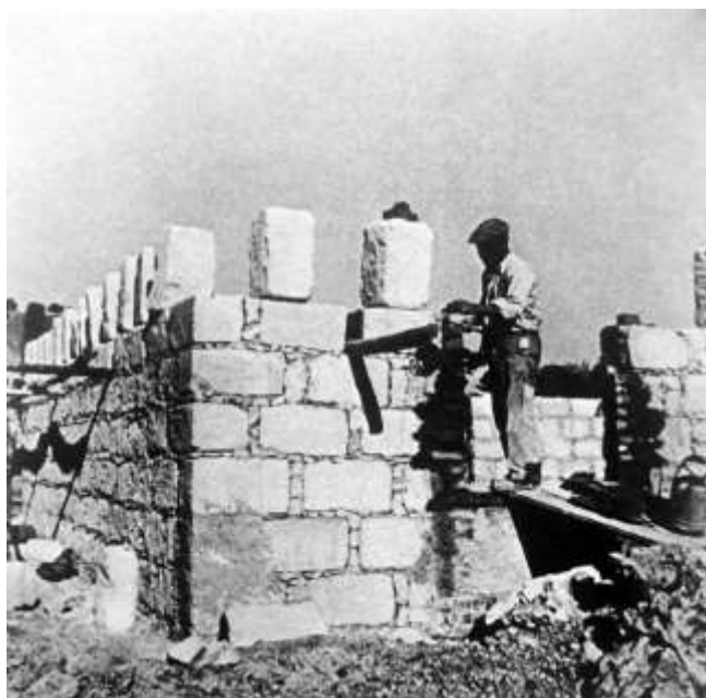
Ilustração 48 – Construção de um edifício em alvenaria de tufo calcário. ([Adaptado a partir de:] Pereira N., Freitas A. e Silva F., 2004)
