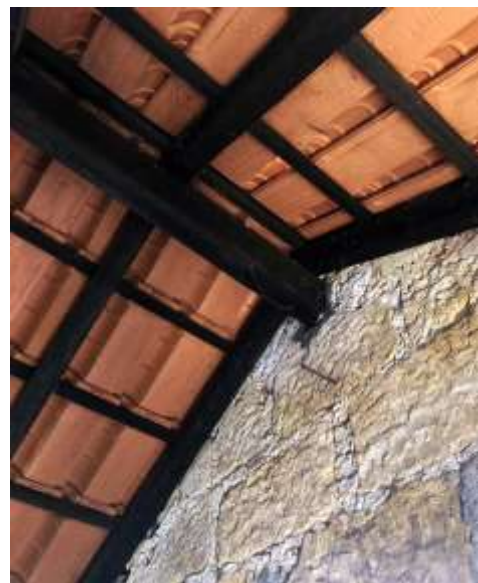
Ilustração 58 – Cobertura com estrutura assente na pedra. (Ilustração nossa, 2021)
