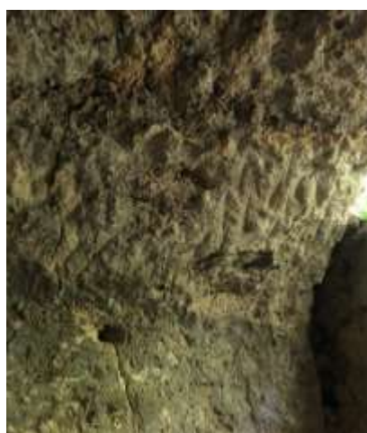
Ilustração 28 – Marcas de ferramenta para aparelhamento de uma gruta. (Ilustração nossa, 2021)
