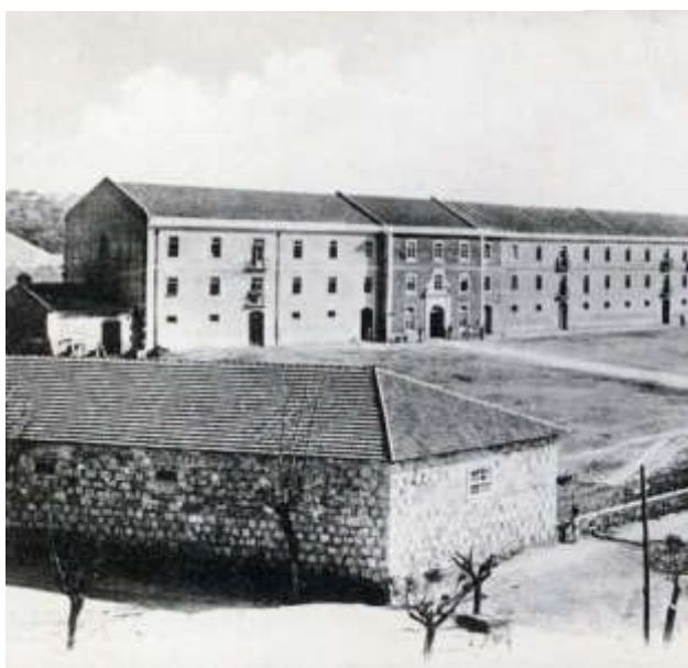
Ilustração 38 – Pavilhão construído em tufo calcário na antiga Escola Prática da Cavalaria (EPP) na primeira década do século XX. ([Adaptado a partir de:] Oliveira J., 1900)
