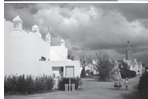
Fig.84 - Construções da Beira Alta no Núcleo das Aldeias Portuguesas, 1940, fotog. Casimiro dos Santos Vinagre.
