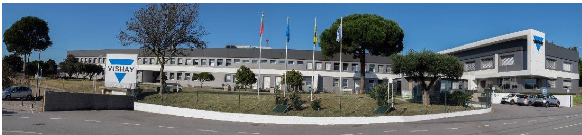
Figura 4 - Ilustração da fachada principal da empresa Vishay
