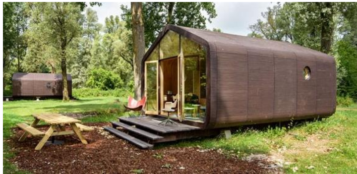
Figura 6.7 - Construção de Casa Modular em Papel (WINKKLEHOUSE, s.d.).
