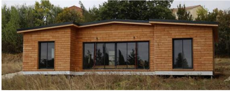
Figura 6.6 - Construção em Blocos de Madeira 2 (BRICAWOOD, s.d.).
