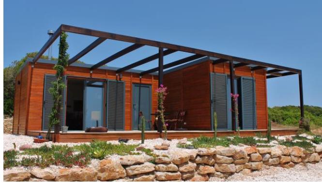
Figura 6.3 - Construção Modular (DiscoverCasa, s.d.).
