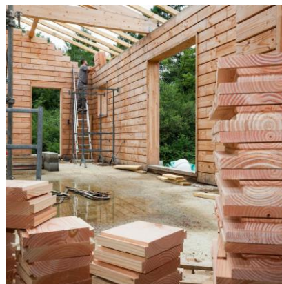
Figura 6.5 - Construção em Blocos de Madeira 1 (BRICAWOOD, s.d.).
