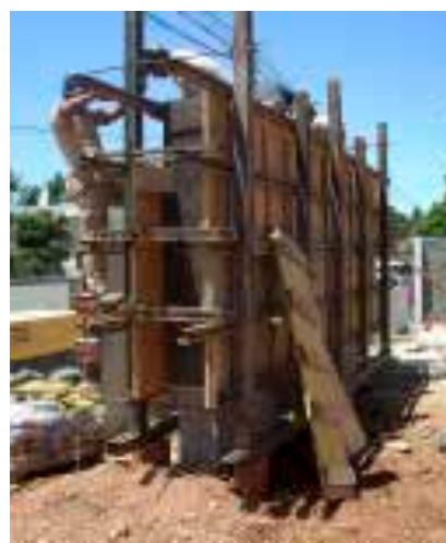
Ilustração 18 – Taipa mecanizada com técnicas tradicionais, obra em Carcavelos. (Betão e taipa, 2020).
