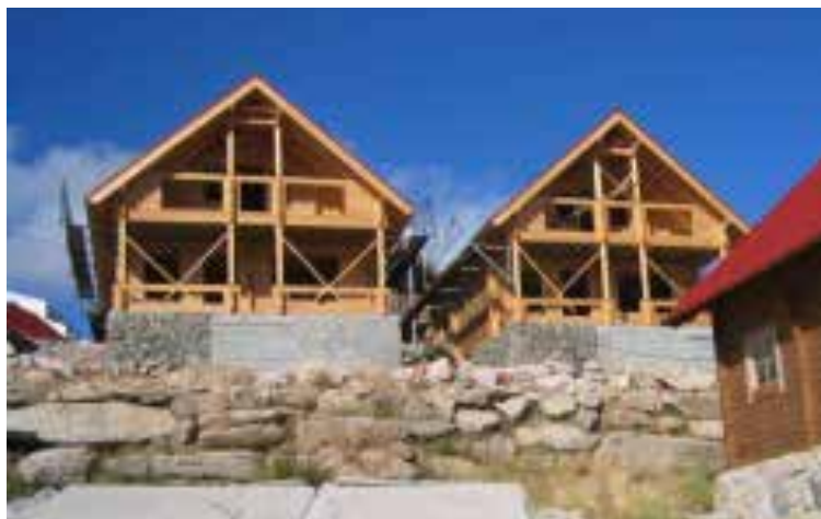
Ilustração 67 – Casas de madeira na Serra da Estrela., Luís Morgado, (Laboratório Nacional de Engenharia Civil, 2010b, p. 158).
