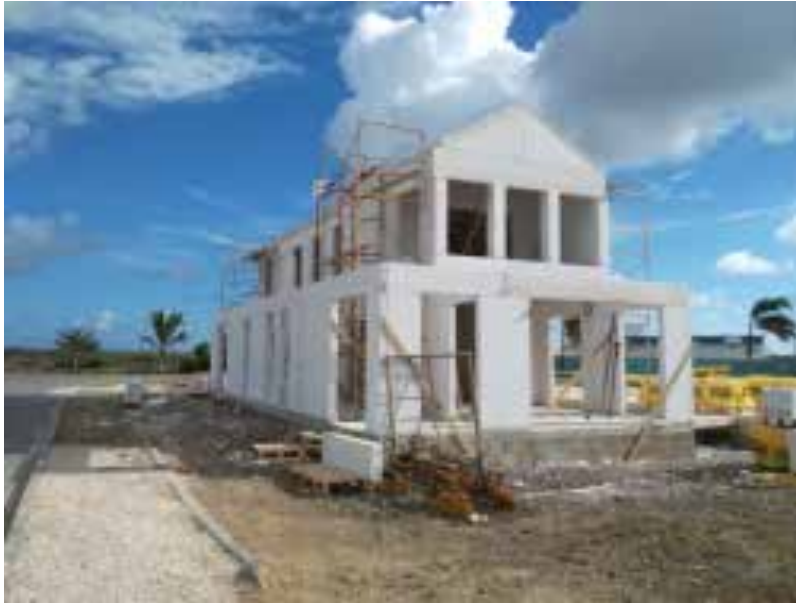
Ilustração 95 – Edifício público construído com blocos de betão celular autoclavado. (Xella - Ytong, 2020).
