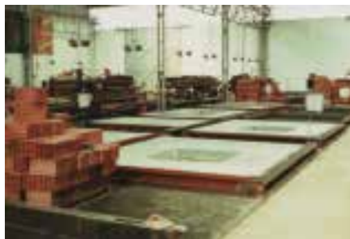
Ilustração 111 – Painéis pré-fabricados de paredes exteriores já acabados, ICESA, 1966. (Pinto, 2001, p. 289).
