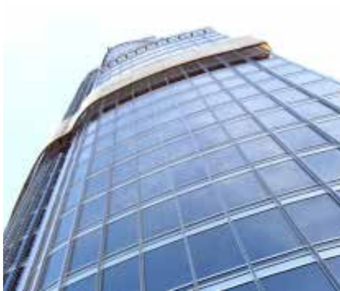
Ilustração 152 – Edifício Burj Khalifa, pormenor de fachada de vidro com sistema de cortina, no Dubai, Emirados Árabes Unidos. (Ilustração nossa, 2016).
