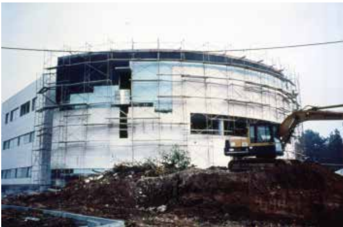
Ilustração 173 –Fase de construção do edifício da Câmara de Oliveira do Bairro, 1999. (Pinto, 2001, p. 291).
