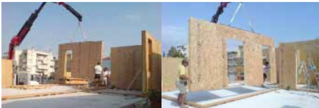
Ilustração 63 – Montagem de paredes portantes aligeiradas, Loghomes.(Laboratório Nacional de Engenharia Civil, 2011, p. A5.19).
