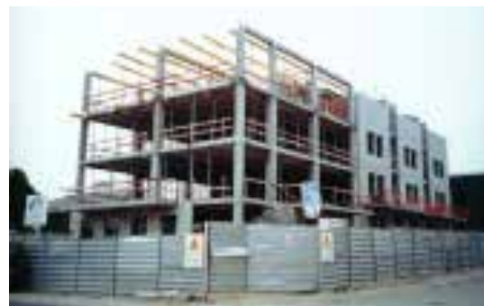
Ilustração 113 – Pré-fabricação linear, em Aveiro, PAVICENTRO, 1998. (Pinto, 2001, p. 301).
