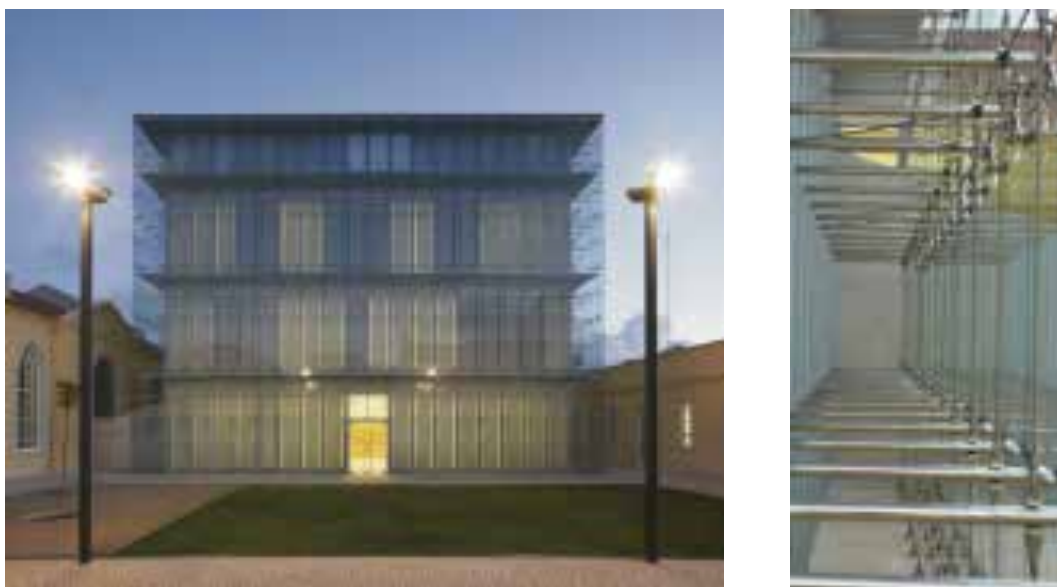
Ilustração 140 – Museu NAC na Marinha Grande com sistema de fachada agrafada ventilada. (Pentagonal, 2019).
