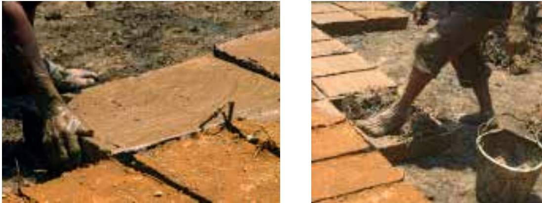
Ilustração 24 – Compactação manual de adobe em molde de madeira, Ignacio Gomez Pulido. (Baraya, 2020).
