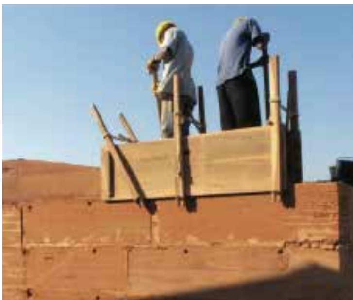
Ilustração 15 – Construção tradicional de parede em taipa, em Moçambique, Miguel Mendes, 2006. (Torgal, Eires e Jalali, 2009, p. 35).
