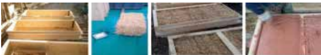
Ilustração 114 – Fases de construção dos painéis pré-fabricados leves. (Pinto e Dias, 2018, p. 18-19).
