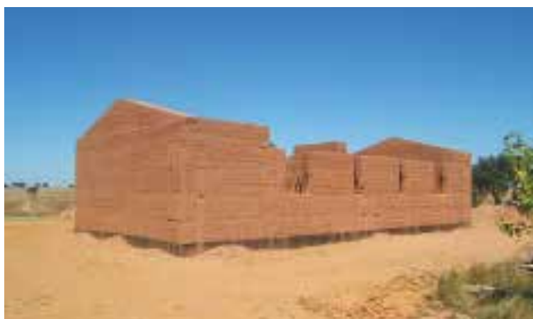
Ilustração 20 – Obra com paredes em taipa mecanizada à vista, obra em Serpa. (Betão e taipa, 2020).
