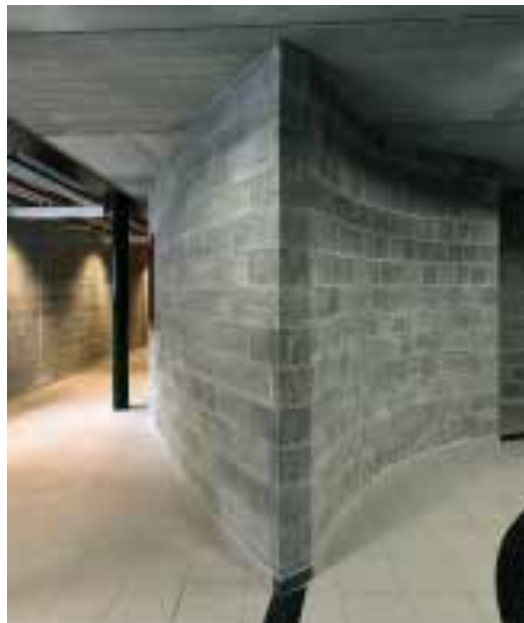
Ilustração 83 – Parede de blocos de betão à vista. (Febe, 2020).
