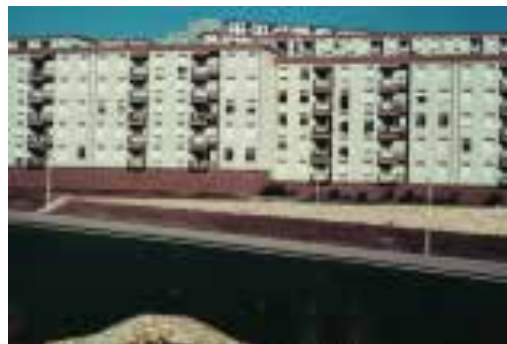
Ilustração 109 – Construção com paredes exteriores pré-fabricadas pesadas de edifícios habitacionais em Santo António dos Cavaleiros, ICESA - SAC, 1967. (Pinto, 2001, p. 300).
