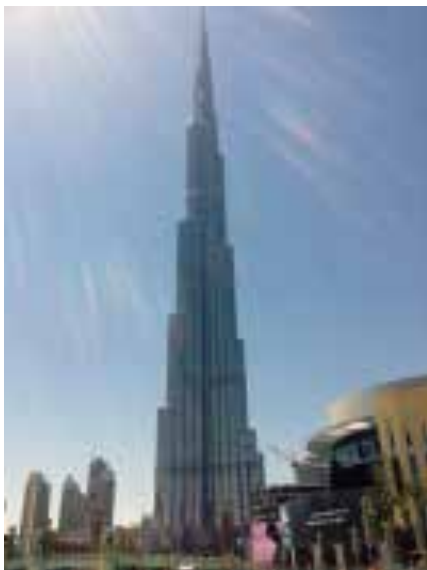
Ilustração 151 – Edifício Burj Khalifa com fachada de vidro com sistema de cortina, no Dubai, Emirados Árabes Unidos. (Ilustração nossa, 2016).
