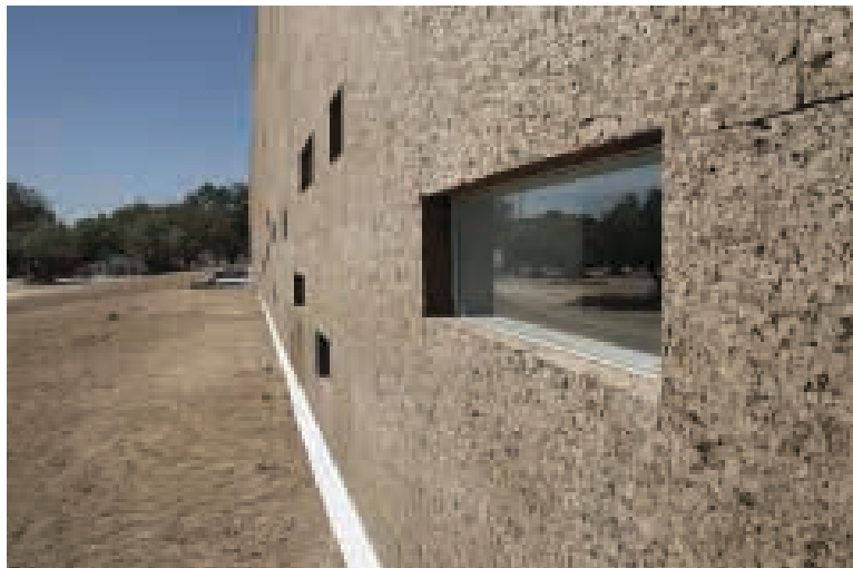
Ilustração 132 – Edifício com sistema ETICS, com isolamento térmico de cortiça (ICB) à vista. (Amorim Cork Insulation, 2020).
