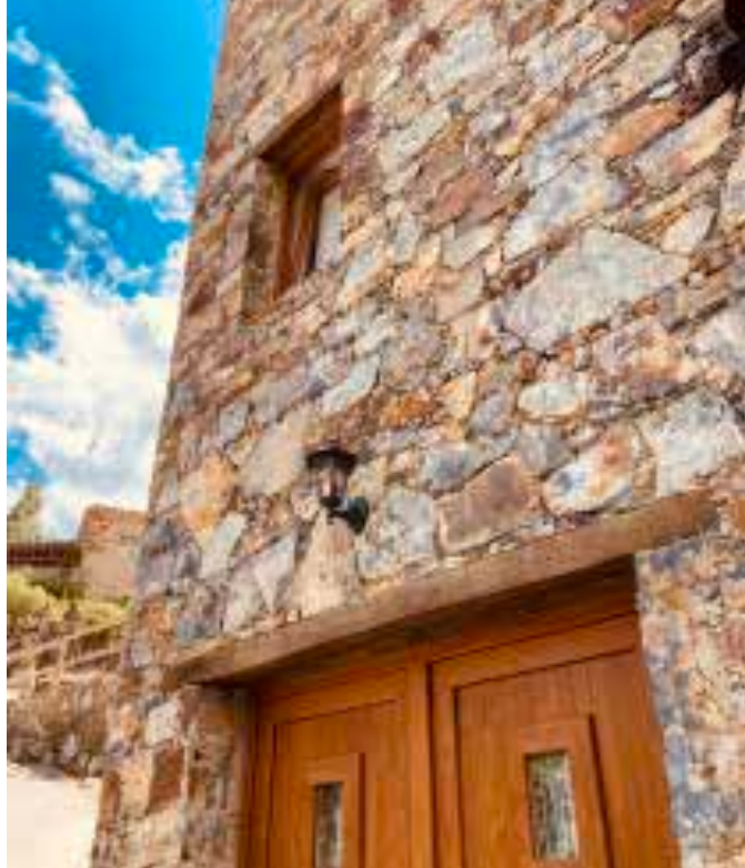
Ilustração 46 – Parede em alvenaria de pedra aparente irregular. (Ilustração nossa, 2020).
