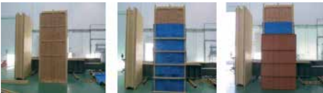
Ilustração 115 – Montagem de acabamento exterior nos painéis pré-fabricados leves. (Pinto, 2018, p. 177).
