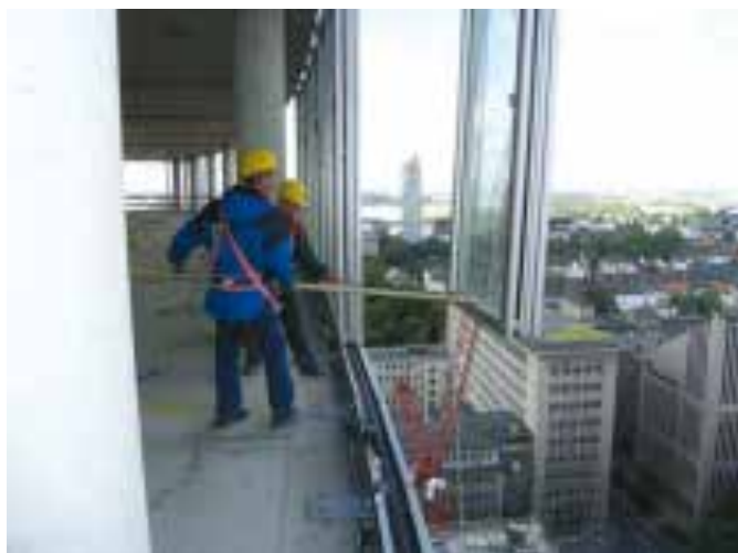
Ilustração 147 – Montagem de elementos pré-fabricados em vidro no sistema de fixação mecânica de cortina. (Halfen, 2020).
