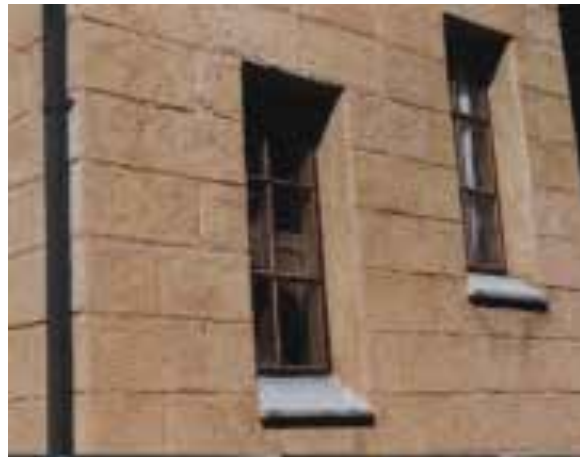
Ilustração 27 – Alvenaria de adobe in situ . (Torgal, Eires e Jalali, 2009, p. 47).
