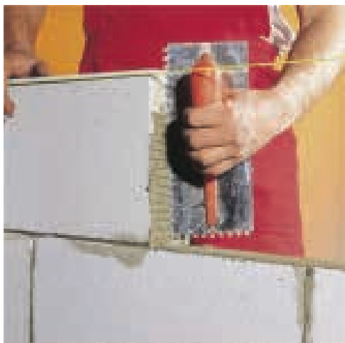
Ilustração 91 – Assentamento e aplicação de argamassa nos blocos com espátula de dentes. (Xella - Ytong, 2020).
