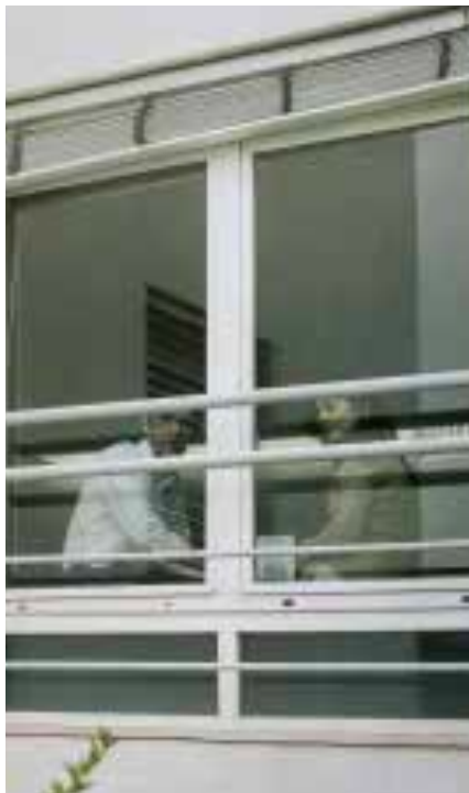
Ilustração 161 – Parede de Trombe não ventilada colocada por baixo de uma janela, ocupando uma faixa na altura de um assento. (Tirone e Nunes, 2007, p. 164).
