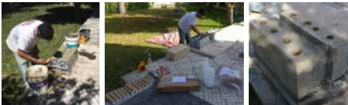
Ilustração 101 – Processo de execução dos blocos de encaixe de baixo carbono em moldes de chapa metálica. (Pinto, 2018, p. 220).
