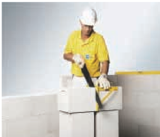
Ilustração 92 – Corte dos blocos de betão celular autoclavado com serrote e esquadro. (Xella - Ytong, 2020).
