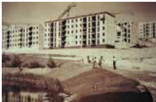
Ilustração 108 – Processo de montagem de paredes exteriores pré-fabricadas pesadas, edifícios em Santo António dos Cavaleiros, ICESA - SAC, 1966. (Pinto, 2001, p. 300).
