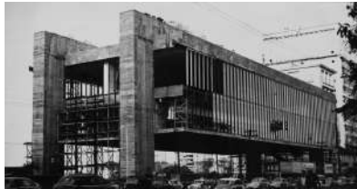
Figura 86 | MASP em processo construtivo - 1950; Figura 87 | Vista do MASP em construção, a partir da avenida 9 de Julho, década de 1960; Figura 88 | MASP em 1968.
