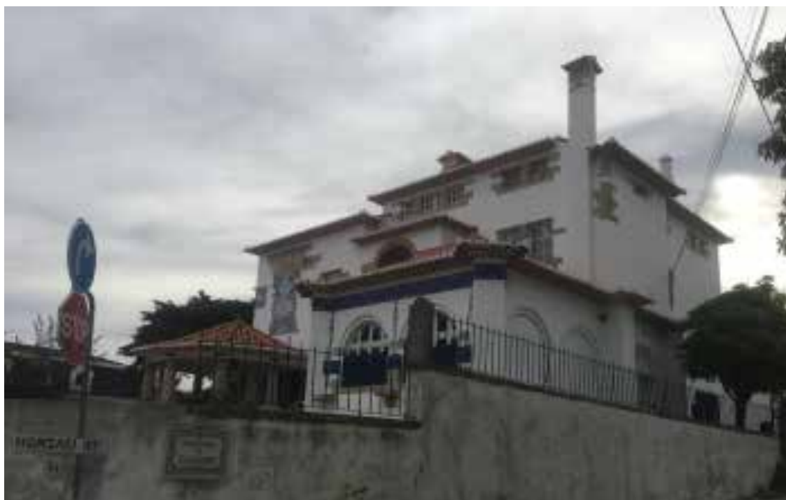
Ilustração 13 — Alçado Este, vista da rua da Calhariz, casa Monsalvat, Raul Lino, 1901, (Ilustração nossa, 2019)
