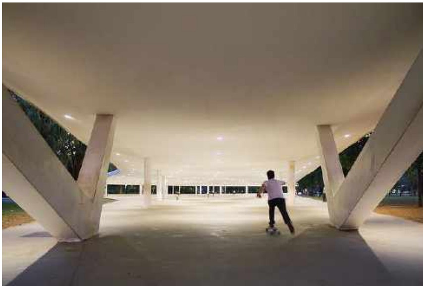
Ilustração 14 - Vazios interiores da marquise do Parque Ibirapuera, Micael Schissel. (Parque Ibirapuera Conservação, 2019).
