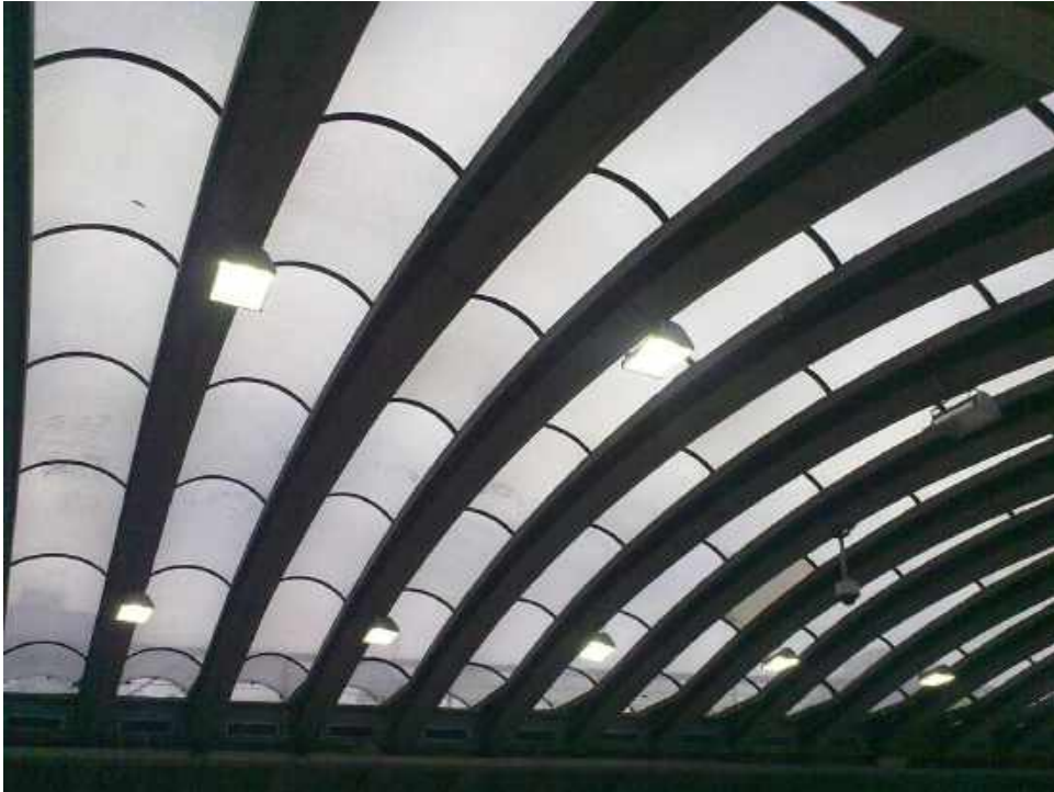
Ilustração 60 - Cobertura metálica do Centro Cultural São Paulo. Leite (Souza, 2014).
