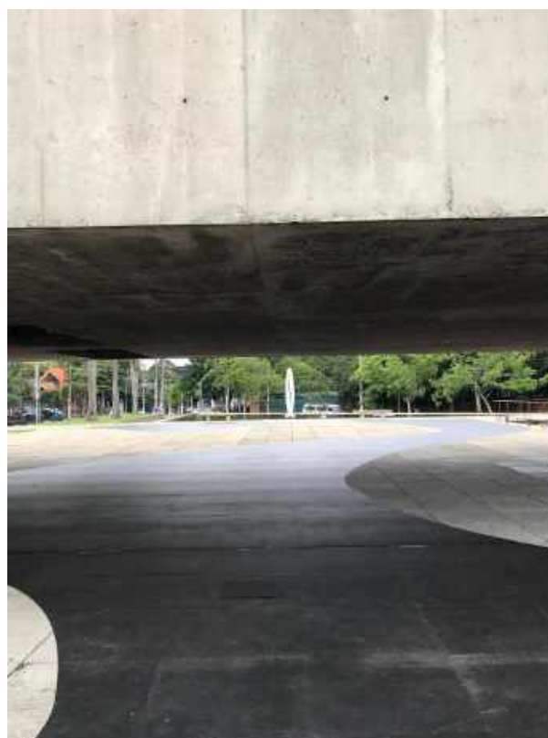
Ilustração 86 - Vista embaixo da laje do museu. (Ilustração nossa, 2018).
