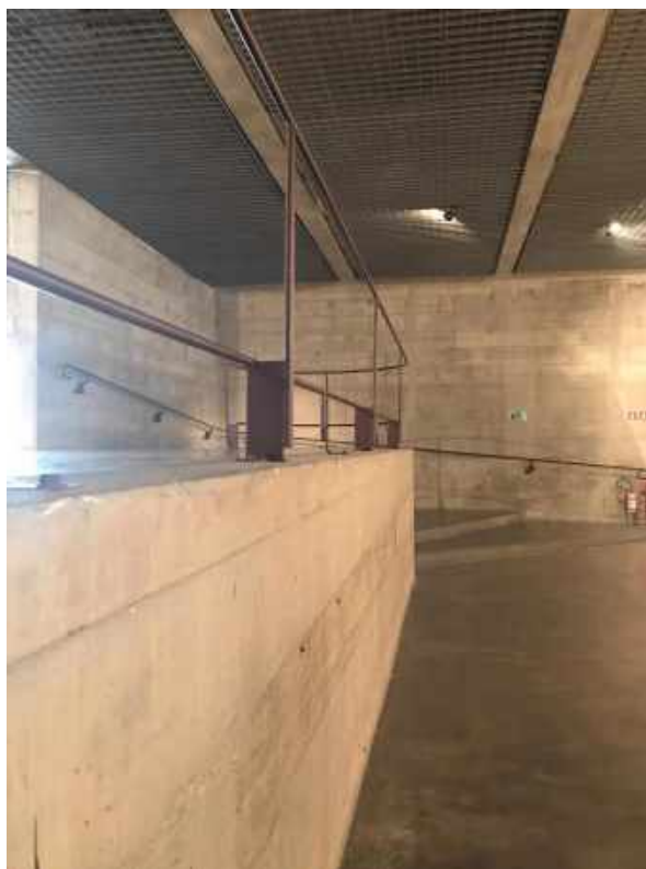
Ilustração 89 - Rampa de acesso Pinacoteca. (Ilustração nossa, 2018).
