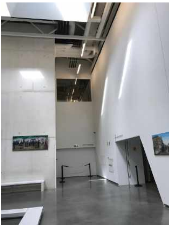
Ilustração 112 - Diferença de escalas entre a entrada do ambiente e seu pé direito. Forma da entrada segue as treliças metálicas estruturais. (Ilustração nossa, 2019).
