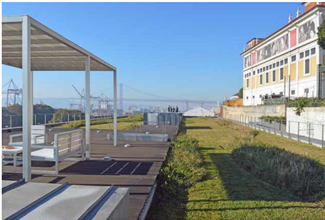
Ilustração 57 - Cobertura da Sede da Cofidis em Lisboa - Projecto de Gonçalo Byrne (Ilustração nossa, 2017)
