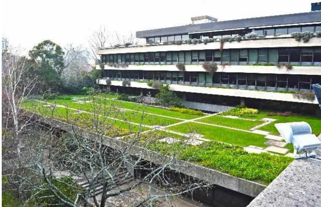
Ilustração 63 - Vista sobre a cobertura da sala de exposições temporárias. (Ilustração nossa, 2017)
