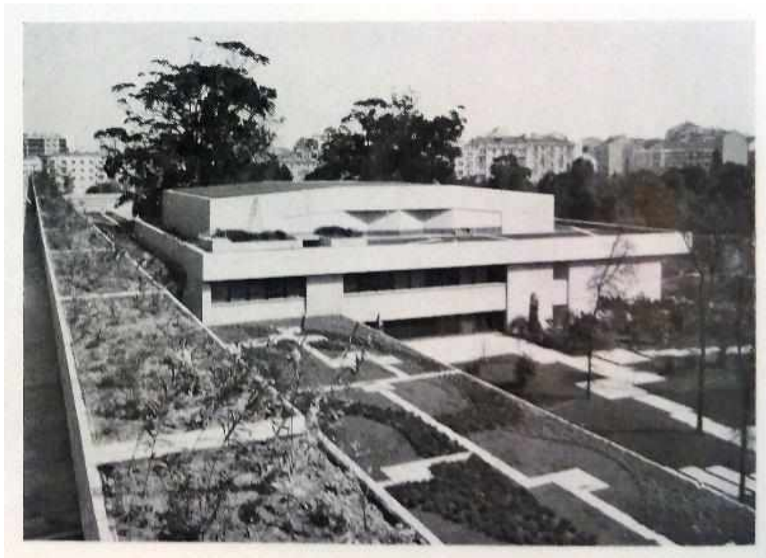
Ilustração 62 – Vista para o Grande Auditório da Fundação Calouste Gulbenkian (AFCG, 1969)
