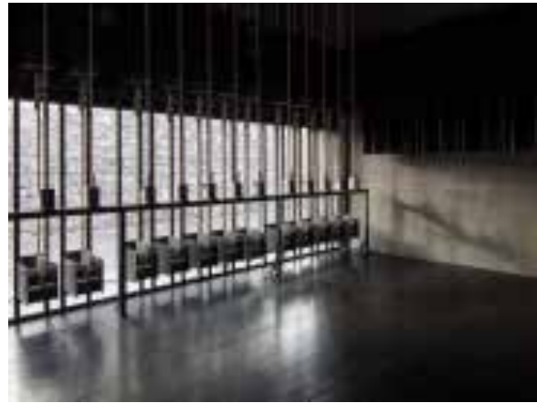
Ilustração 215 – sistema de contra-pesos, ACAC, José Campos, 2015. (cortesia do Arquiteto João Mendes Ribeiro, 2019)
