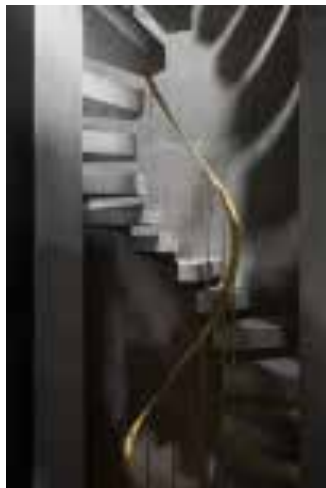
Ilustração 242 – escada de acesso à teia, José Campos, 2015. (Cortesia do Arquiteto João Mendes Ribeiro, 2019).
