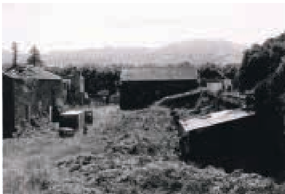
Ilustração 180 – Preexistência, antes da intervenção.(cortesia do Arquiteto João Mendes Ribeiro, 2019).
