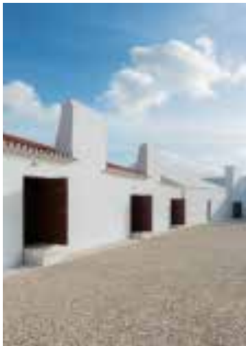
Ilustração 151 – manutenção da cal tradicional e das portas de madeira, colocando no interior portas de vidro. do mal o menos, Eduardo Nascimento e João Fôja, 2014. (cortesia do Arquiteto João Mendes Ribeiro, 2019)
