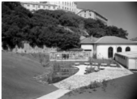
Ilustração 8 - Vista dos jardins da AAC em 1963, nesta imagem pode-se reparar na permanência da central térmica após o Plano para a Alta de Coimbra. (Leite, 2013).
