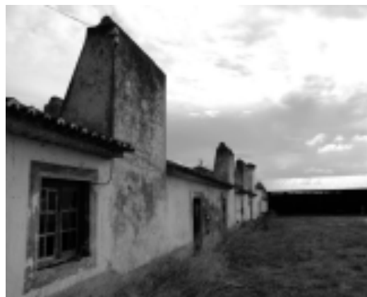
Ilustração 78 – Fachada da casa dos operários em banda, marcadas pelas características chaminés, João Mendes Ribeiro, 2015. (cortesia do Arquiteto João Mendes Ribeiro, 2019).
