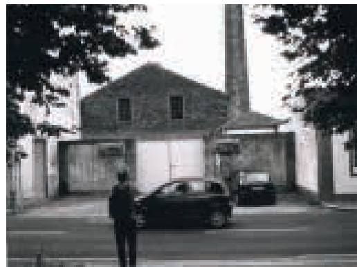
Ilustração 181 - Preexistência, antes da intervenção.(cortesia do Arquiteto João Mendes Ribeiro, 2019).
