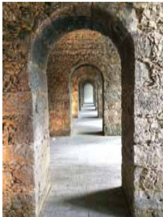
Ilustração 227 - Cave, estrutura abobadada, (Ilustração Nossa, 2017).
