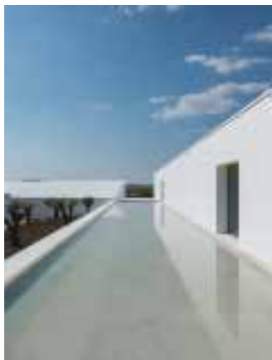
Ilustração 163 – espelho de água que funciona como refrigeração para o interior da adega. do mal o menos, Eduardo Nascimento e João Fôja, 2014 (cortesia do Arquiteto João Mendes Ribeiro, 2019)
