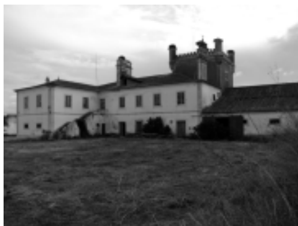
Ilustração 74 – Vista geral do Edifício Central, em estado de abandono. João Mendes Ribeiro, 2015. (cortesia do Arquiteto João Mendes Ribeiro, 2019).
