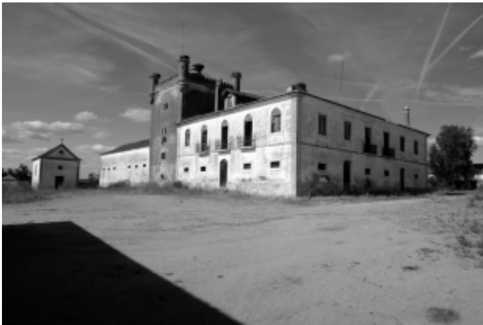
Ilustração 67 - Edifício Central, lado sueste em estado de abandono, João Mendes Ribeiro, 2015. (cortesia do Arquitecto João Mendes Ribeiro, 2019).
