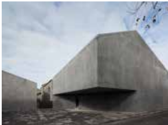
Ilustração 233 - Acesso ao interior do centro, passagem tensa entre edifícios, José Campos, 2015.(Cortesia do Arquiteto João Mendes Ribeiro, 2019).
