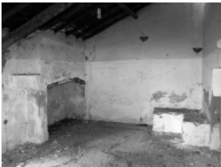
Ilustração 80 - Interior da casa dos operários, João Mendes Ribeiro, 2015. (cortesia do Arquiteto João Mendes Ribeiro, 2019)
