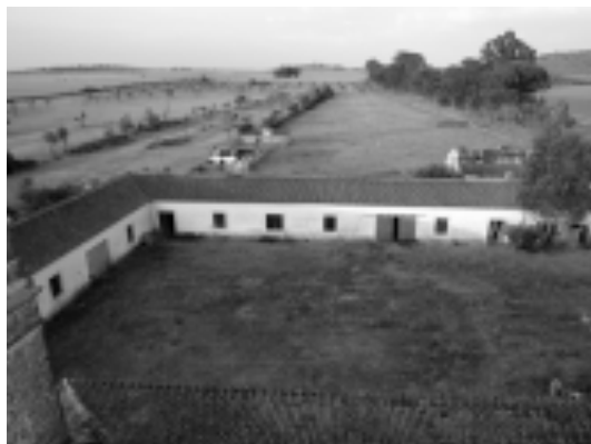
Ilustração 75 – Antigas Casas dos Operários, vista da torre, João Mendes Ribeiro, 2015. (cortesia do Arquiteto João Mendes Ribeiro, 2019).
