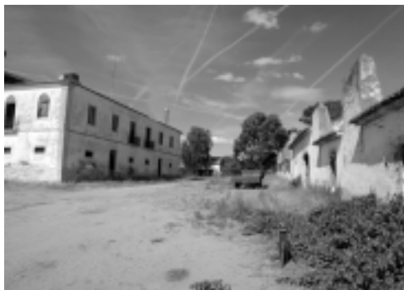
Ilustração 77 – Casa- Mãe (esq.) e antigas casas dos operários (dir.), João Mendes Ribeiro, 2015.(cortesia do Arquiteto João Mendes Ribeiro, 2019).
