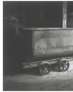
Ilustração 15 – Interior da central térmica, vagoneta inferior, João Mendes Ribeiro, 1999. (Ribeiro, 2003, p. 126)
