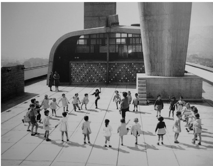
Ilustração 15 – Cobertura do Bloco de Marselha., René Burri. (Vitra Design Museum, 2017).
