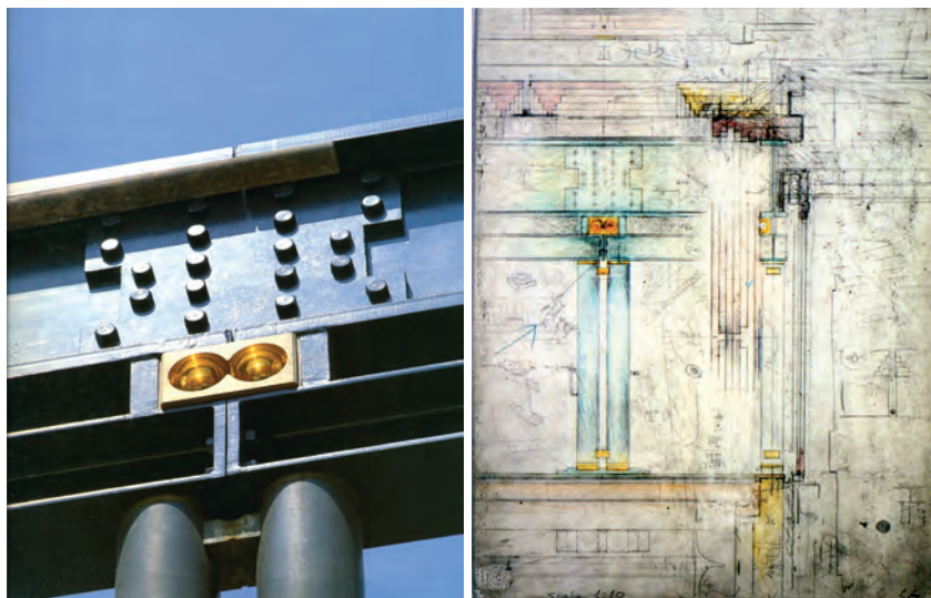
Fig.2 - Carlo Scarpa, Banca Popular de Verona, 1973. Pormenor da união das colunas com o entablamento. Scarpa, Carlo, Scarpa. L'architettura nel dettaglio , Gustavo Gili, Milão, 1989, p. 82.
