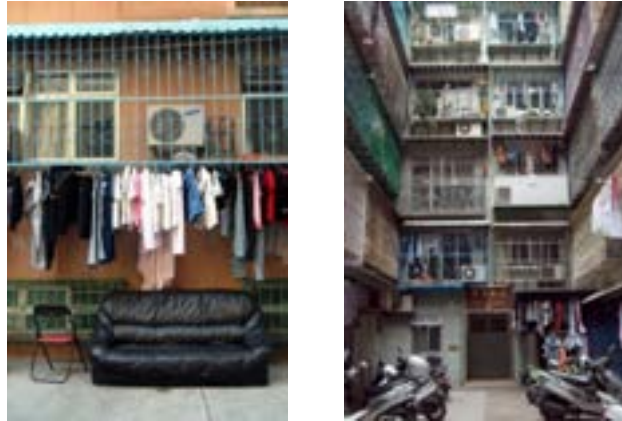
Ilustração 34- Grades, chamadas de gaiolas, presentes na maioria dos edifícios de habitação do território de Macau. (MJ, 2007 e 2008).
