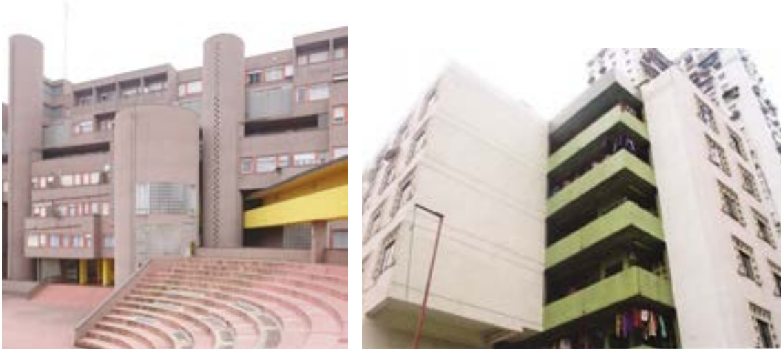
Ilustração 60- Em cima, pormenor das varandas o Fai Chi Kei (Afonso, 2011, p. 111); em baixo, Gallarate, pormenor da galeria amarela que trespassa o volume para o exterior. (Fiederer, 2017).
