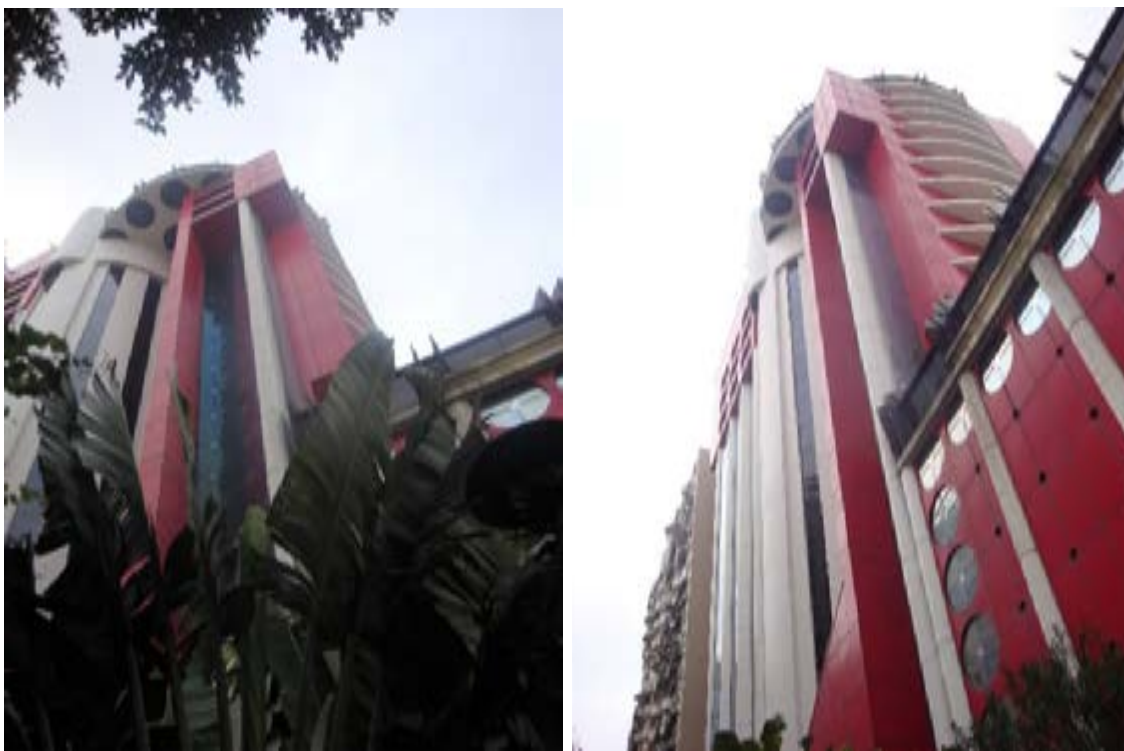
Ilustração 42- Em cima, edifício do WTC, imagens exemplificativas do uso literal da bobine de cinema ou roda de engrenagem como elemento decorativo e estrutural da fachada. (Ilustração nossa, 2014).
