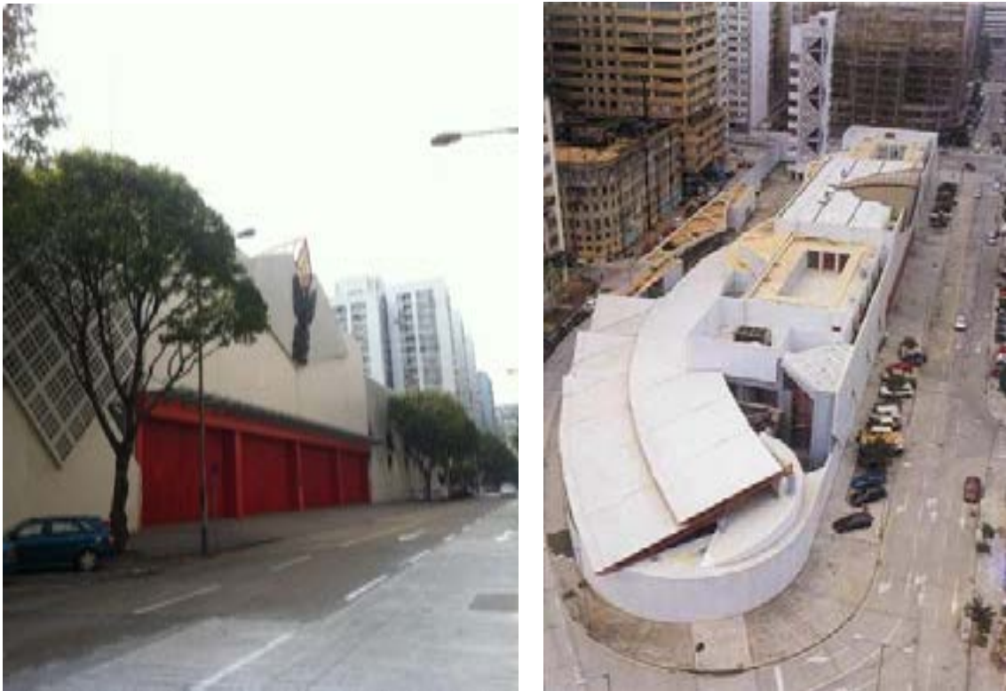
Ilustração 40- Da esquerda para a direita, entrada das garagens do POBAP, Estrada Marginal da Areia Preta (Ilustração nossa, 2014); vista aérea do POBAP a partir da intersecção com a Avenida do Dr. Francisco Vieira Machado. (Botas, 2009).
