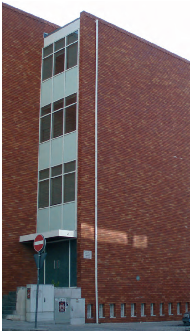
Fig. 8 - Edifício Sede da Cooperativa Agrícola de Alcobaça. Pormenor dos planos da fachada.
