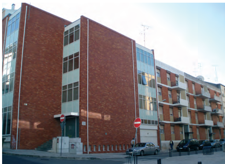
Fig. 11 - Edifício Sede da Cooperativa Agrícola de Alcobaça e Bloco Residencial. Articulação do conjunto.
