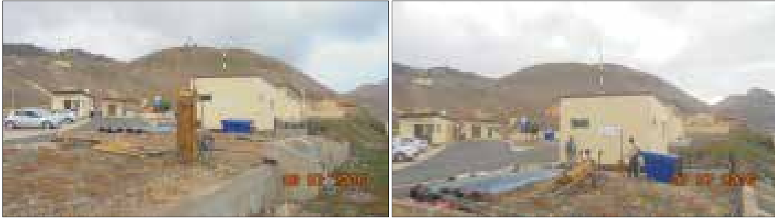
Ilustração 39 – Trabalhos de prospeção geotécnica. (Ilustração nossa, 2016).
