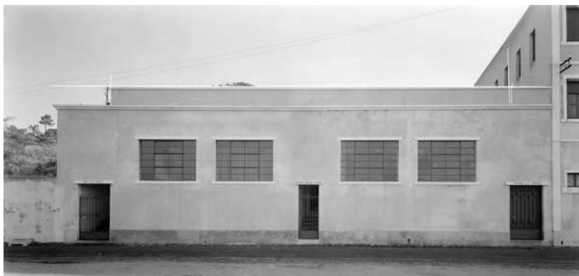
Ilustração 26 - fachada do edifício dos Refeitórios da Mundet Seixa realizada entre 1930 e 1988. (EMS-CDI)
