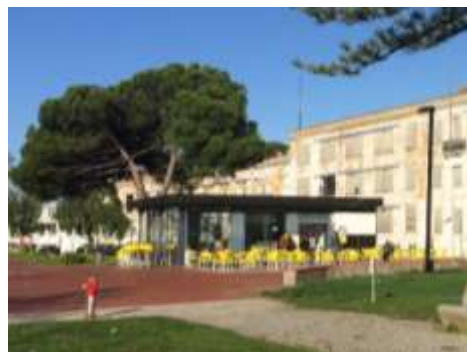
Ilustração 42 – café construído no lugar da antiga casa do cais. (Ilustração nossa)
