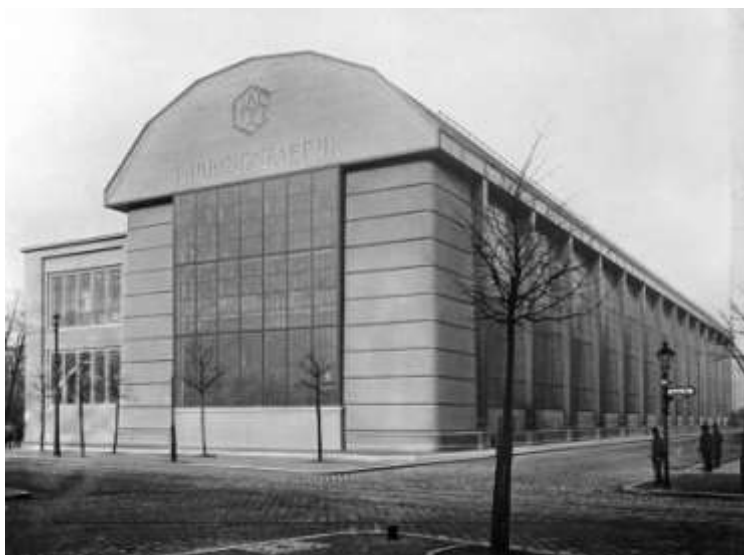
Ilustração 7 - Fábrica de Turbinas AEG. ([Adaptado a partir de:] bauarquitectos, 2016 )
