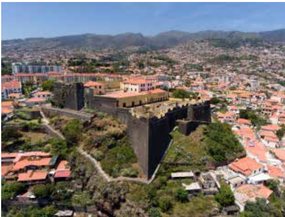
Ilustração 69 – Fotografia aérea da Fortaleza de São João Baptista. (Ilustração nossa, 2017).
