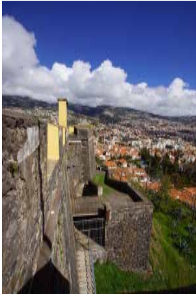
Ilustração 123 – Rampa de acesso ao revelim e ponte levadiça. (Ilustração nossa, 2018)
