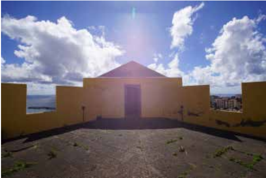
Ilustração 121 – Entrada para a guarita do baluarte de São João. (Ilustração nossa, 2018).
