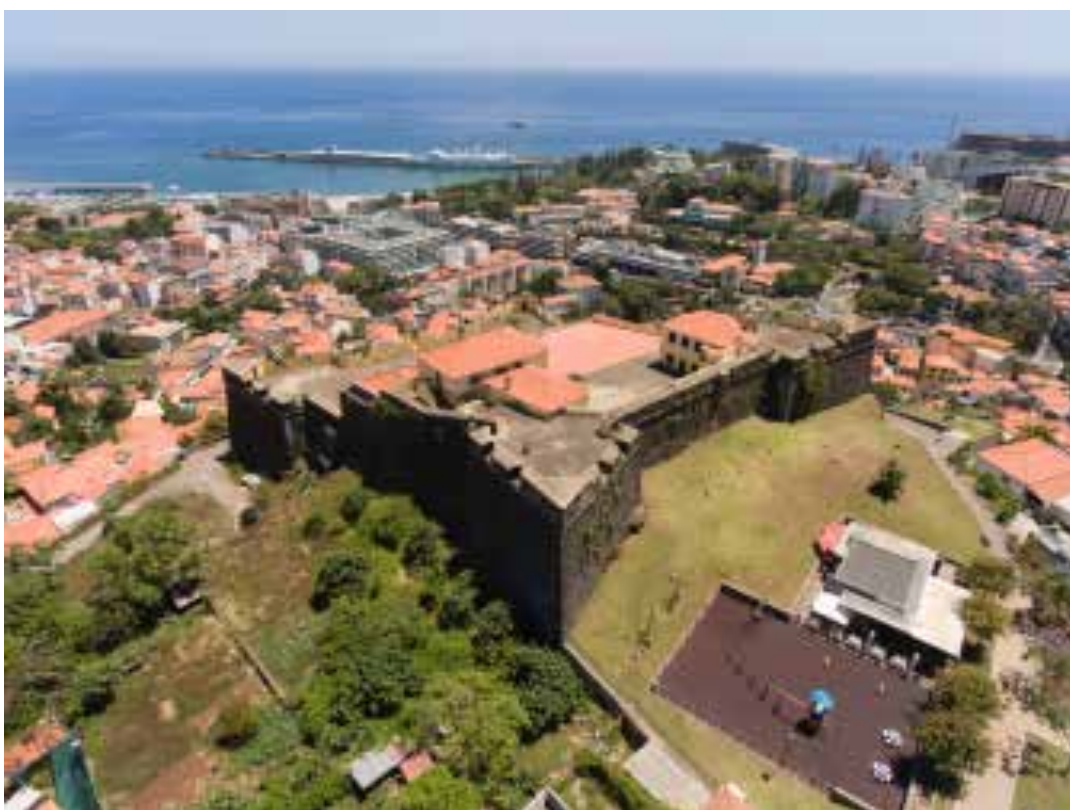
Ilustração 126 – Vista aérea do lado norte da Fortaleza de São João Baptista. (Ilustração nossa, 2017).
