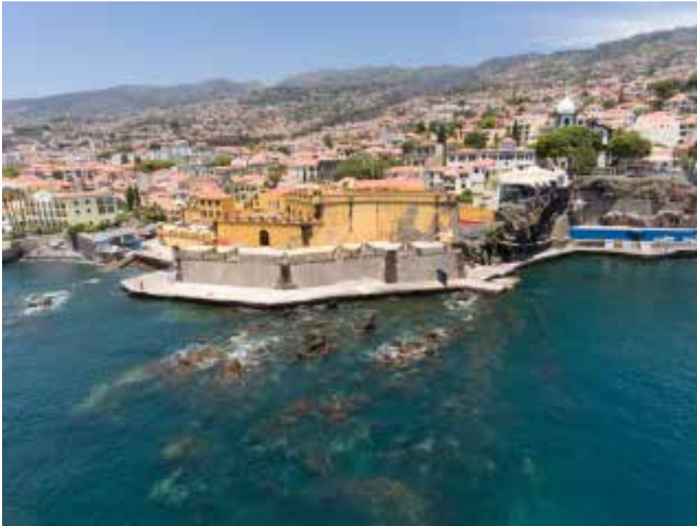
Ilustração 103 – Fortaleza de São Tiago, fortificação marítima. (Ilustração nossa, 2017).
