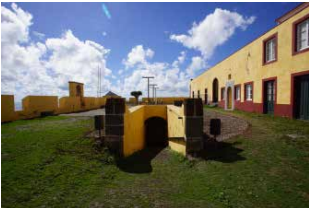
Ilustração 119 – Escada de acesso à esplanada baixa da Fortaleza de São João Baptista. (Ilustração nossa, 2018).
