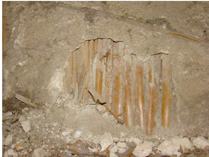
Ilustração 19 – Parede divisória de madeira e cana. Tavira. (Ilustração nossa 2009)
