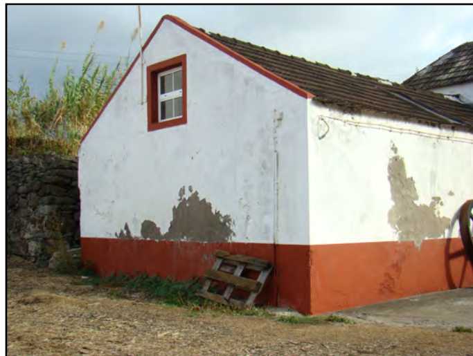
Ilustração 24 – Incompatibilidade entre o material de suporte e revestimento agrava o aparecimento de patologias, Porto da Cruz, Ilha da Madeira. (Ilustração nossa 2011)
