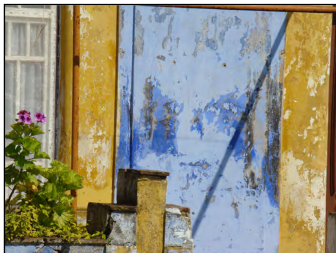
Ilustração 50 – Descoloração dos pigmentos, Tavira. (Ilustração nossa, 2010)
