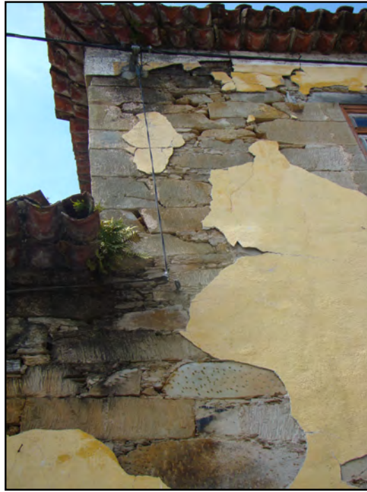
Ilustração 17 – Destacamento do reboco, Coja. (Ilustração nossa, 2010)
