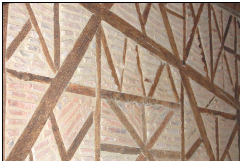
Ilustração 18 – Parede divisória de madeira e tijolo. Mosteiro de Tibães, Braga. (Ilustração nossa, 2010)
