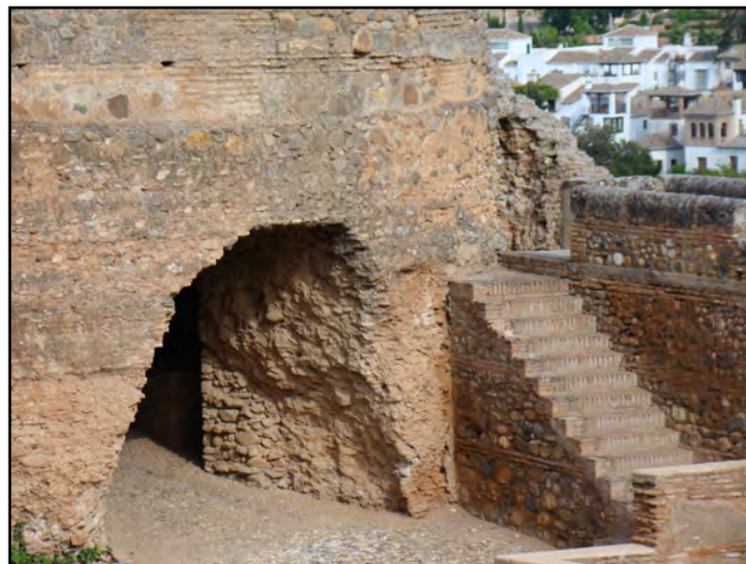
Ilustração 10 – Generosa parede exterior, Palácio de Alhambra, Granada. (Ilustração nossa, 2010)
