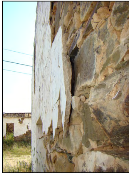
Ilustração 25 – Reboco com falta de manutenção, Castro Marim. (Ilustração nossa 2011)
