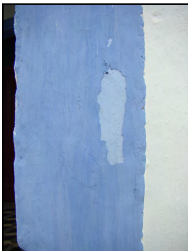
Ilustração 51 – Retoque com pigmento diferente, Montemor-o-Novo. (Ilustração nossa, 2010)
