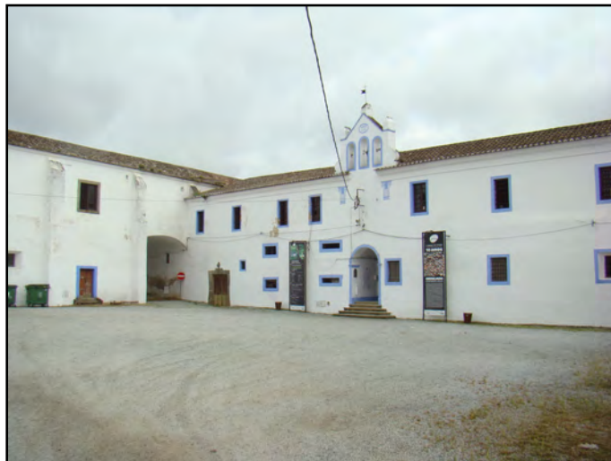
Ilustração 46 – Paramento de grandes dimensão. Montemor-o-Novo. (Ilustração nossa, 2010)
