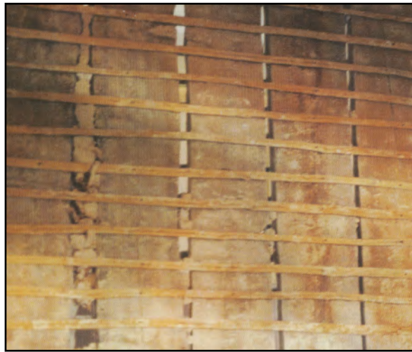
Ilustração 26 – Estrutura de madeira de uma parede de tabique. Reabilitação de edifícios antigos. (Appleton, 2003, p. 32)
