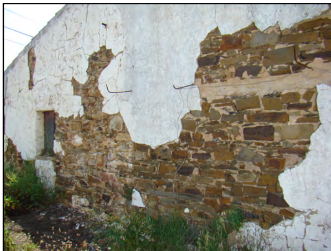
Ilustração 16 – Paramento com reboco danificado, Castro Marim. (Ilustração nossa, 2011)
