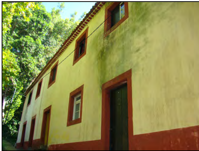
Ilustração 23 – Paramento sem exposição solar directa em ambiente húmido, Monte, Ilha da Madeira. (Ilustração nossa 2011)
