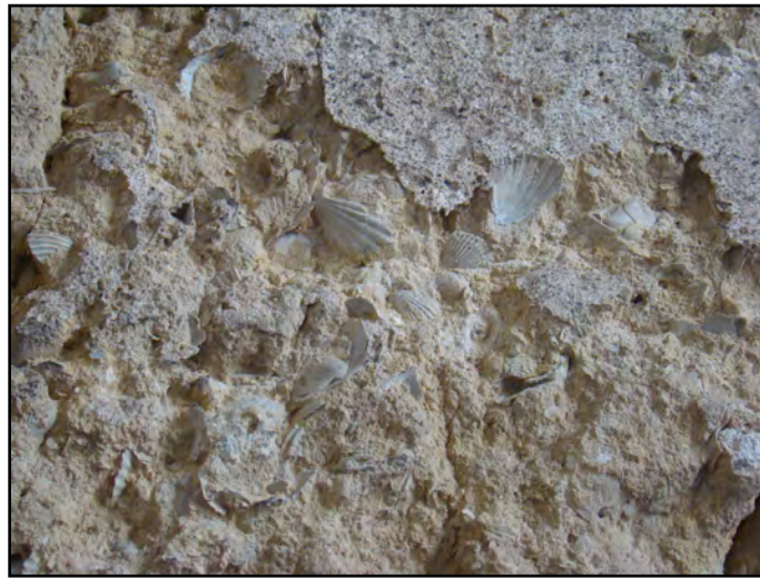
Ilustração 13 – Reboco exterior, Córdoba. (Ilustração nossa, 2010)
