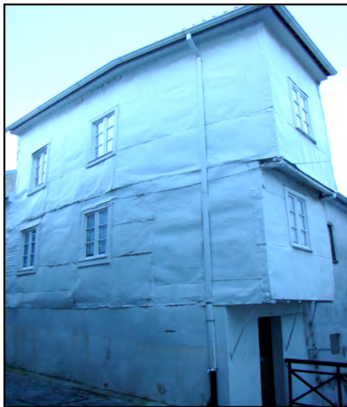
Ilustração 21 – Revestimento desadequado em edifício, Manteigas. (Ilustração nossa 2011)
