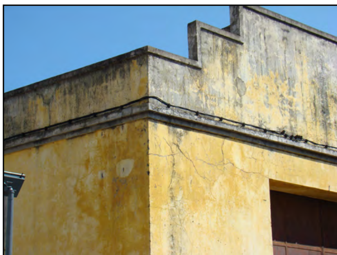
Ilustração 55 – Manchas e falta de manutenção, Tavira. (Ilustração nossa, 2010)
