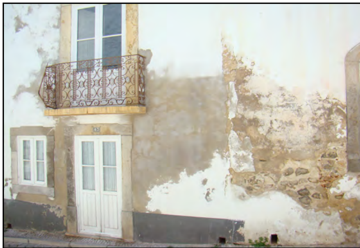
Ilustração 22 – Paredes exteriores com elevado nível de degradação, Tavira. (Ilustração nossa 2010)
