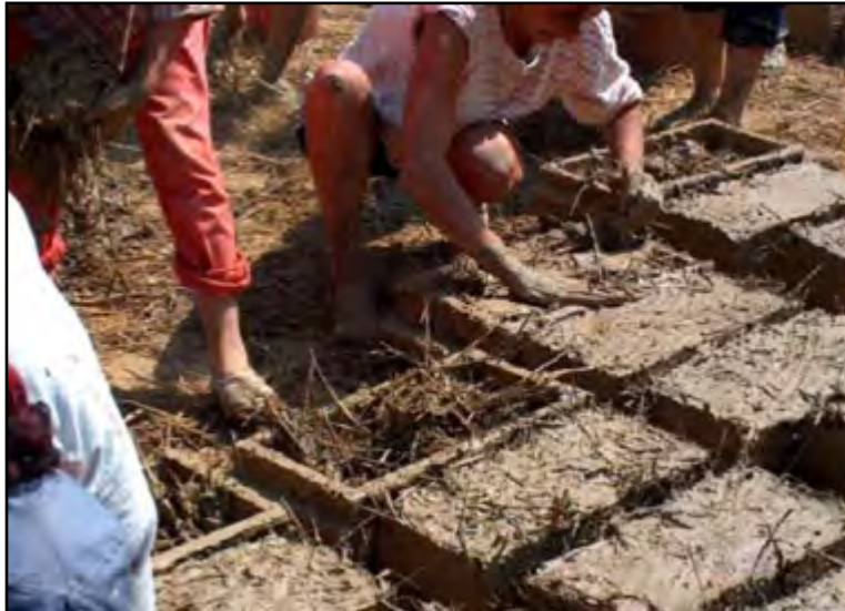
Ilustração 30 – Blocos de adobe com adição de palha (Miguel, 2008, p. 7)
