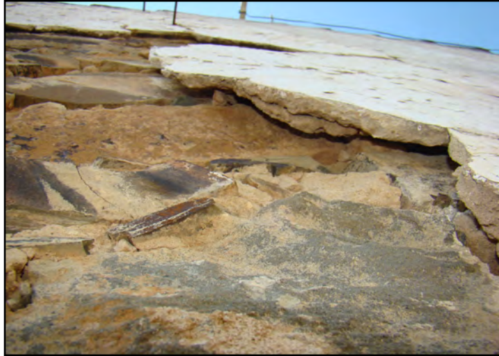
Ilustração 20 – Reboco destacado do suporte, Castro Marim. (Ilustração nossa, 2011)
