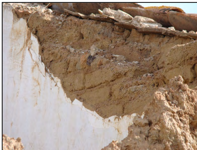
Ilustração 33 – Parede de adobe. Mourão. (Ilustração nossa, 2010)
