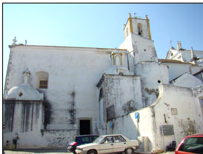
Ilustração 53 – Manchas nos paramentos, Tavira. (Ilustração nossa, 2009)
