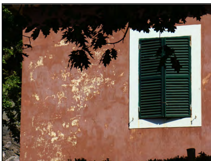
Ilustração 56 – Destacamento da pintura, Monte, Ilha da Madeira. (Ilustração nossa, 2011)
