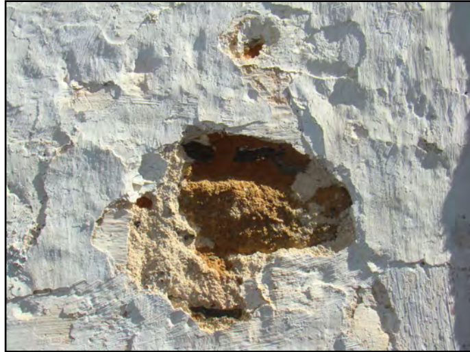
Ilustração 47 – Camadas de caição danificada, Sesimbra. (Ilustração nossa, 2010)
