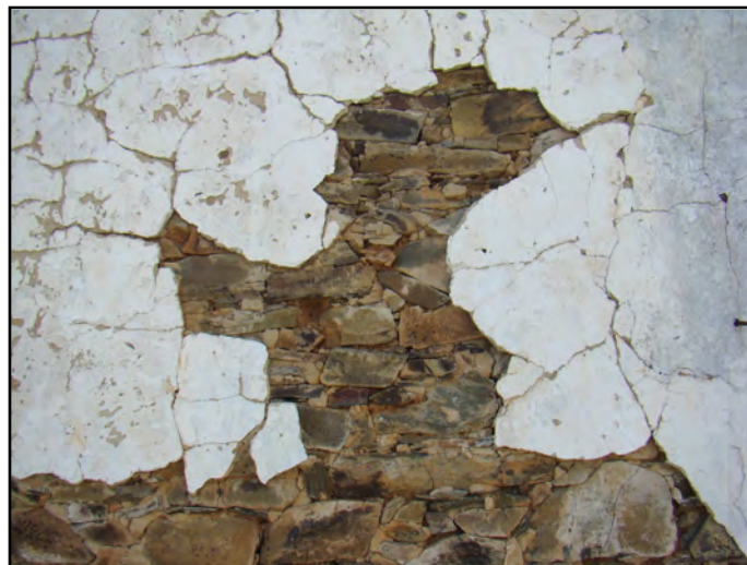
Ilustração 48 – Camada de sacrifício completamente danificada, Castro Marim. (Ilustração nossa, 2010)
