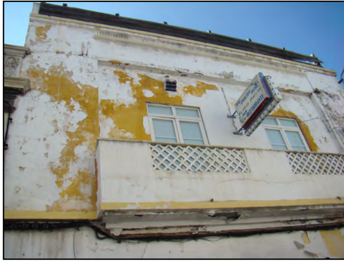
Ilustração 57 – Destacamento da pintura, Tavira. (Ilustração nossa, 2011)
