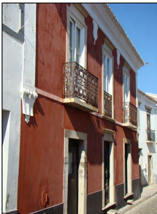
Ilustração 39 – Acabamento rosa velho a necessitar de manutenção, Tavira. (Ilustração nossa, 2011)
