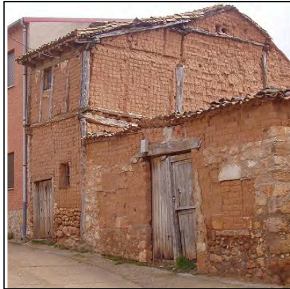
Ilustração 32 – Edifícios construídos em adobe (Guimarães, 2009, p. 33)
