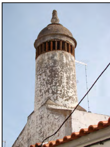
Ilustração 54 – Chaminé com falta de manutenção, Mourão. (Ilustração nossa, 2010)
