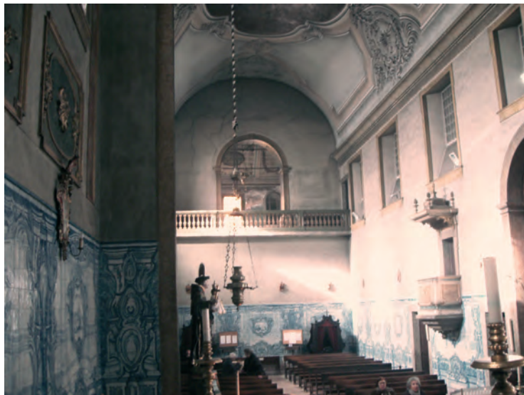
Foto 14 - Vista da nave, púlpito e coro alto
