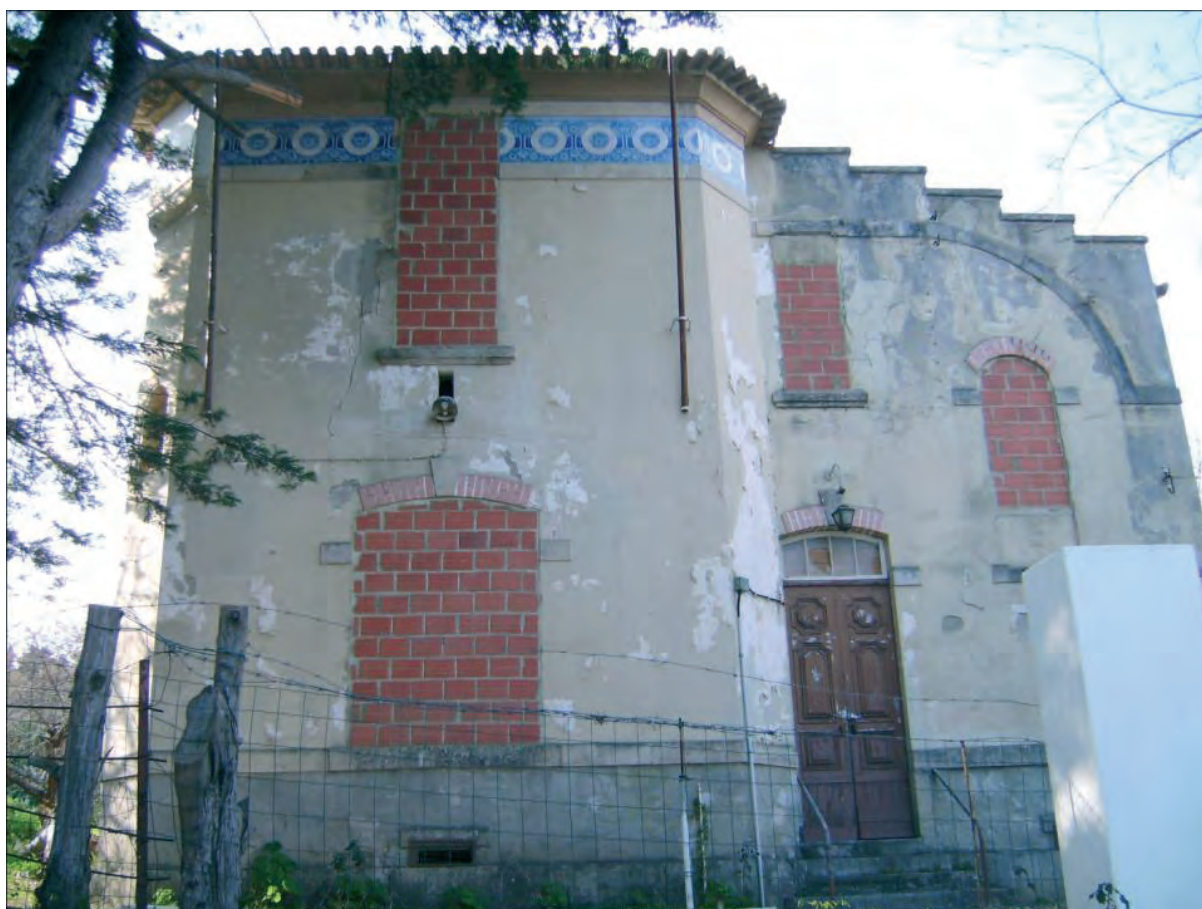
Fig. 19 – Edifício que foi a “Colónia da Sineta”, alçado principal. [Foto ACA, 2011]
