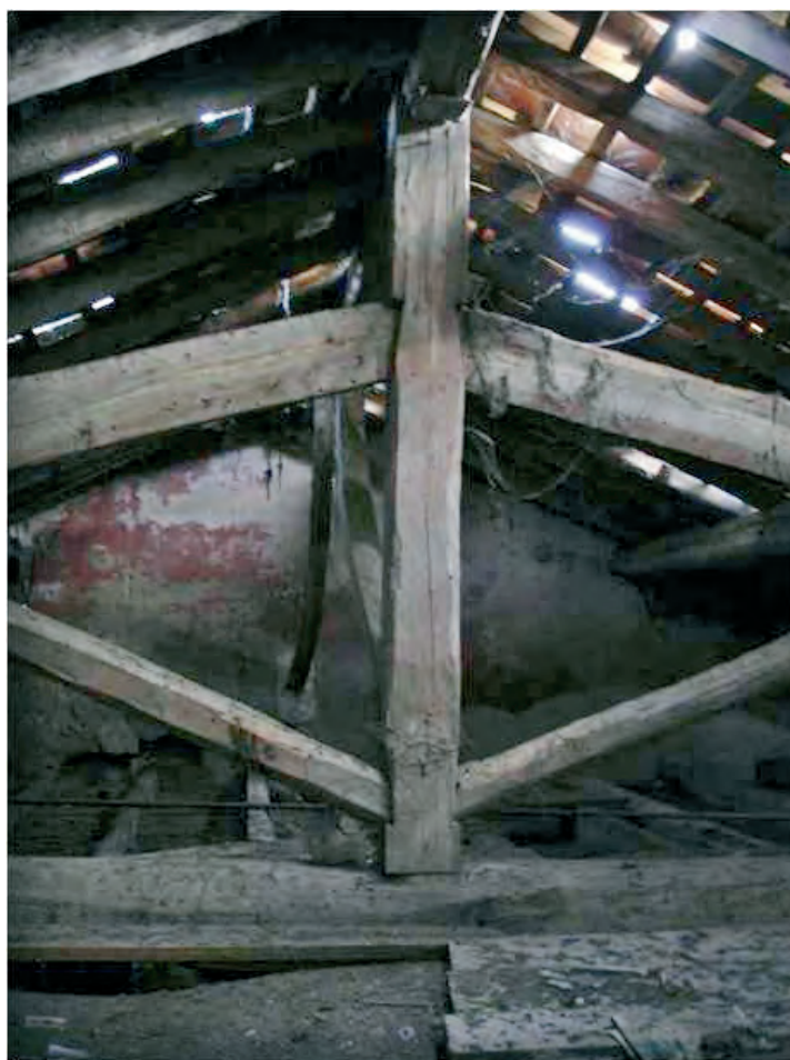
Fig. 10 - Casa Rural – Golegã. Asna e cobertura a telha vã. Luís Mota Figueira 2011
