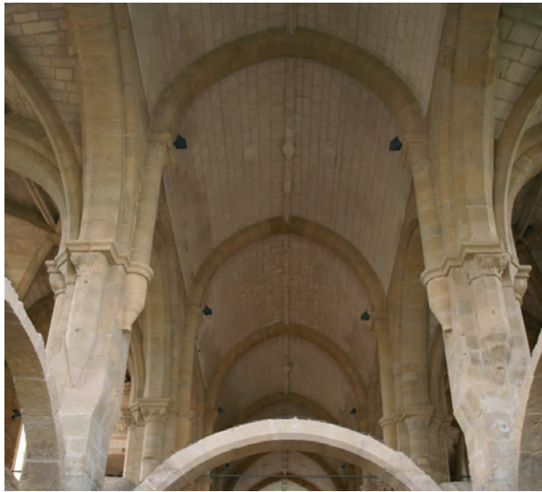
Fig. 10 - Vista interior da nave de Santa Clara a Velha, onde se nota a abóbada de canhão de influência cistercense.
