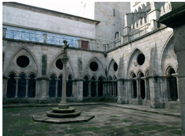
Fig. 7 - Claustro da Sé do Porto, onde se notam as características da arquitectura cistercense.
