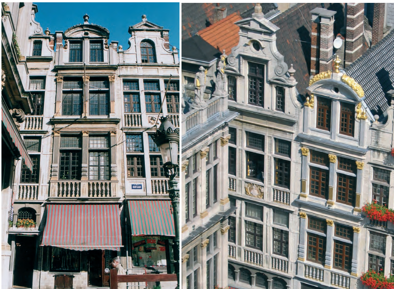
Figure 2: Maison « L'Ane » avant et après restauration, 1999, 2004
