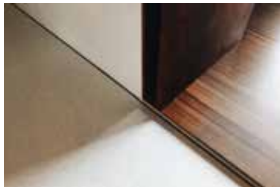
Ilustração 103 Pormenor acesso à sala de leitura. (Ilustração nossa, 2017)
