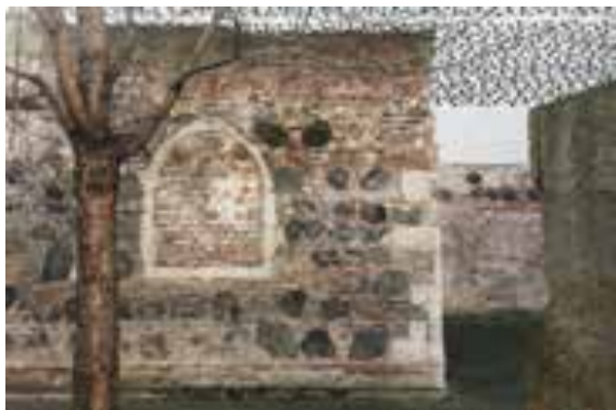
Ilustração 138 Pormenor fachada Museu Kolumba – parede antiga sacristia. (Ilustração nossa, 2017)
