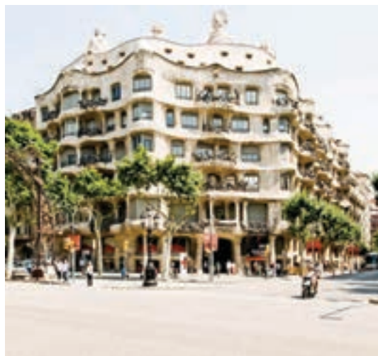
Ilustração 13 - Casa Milá: Barcelona, Espanha – Fachada Principal. (Ludwig, 2016).
