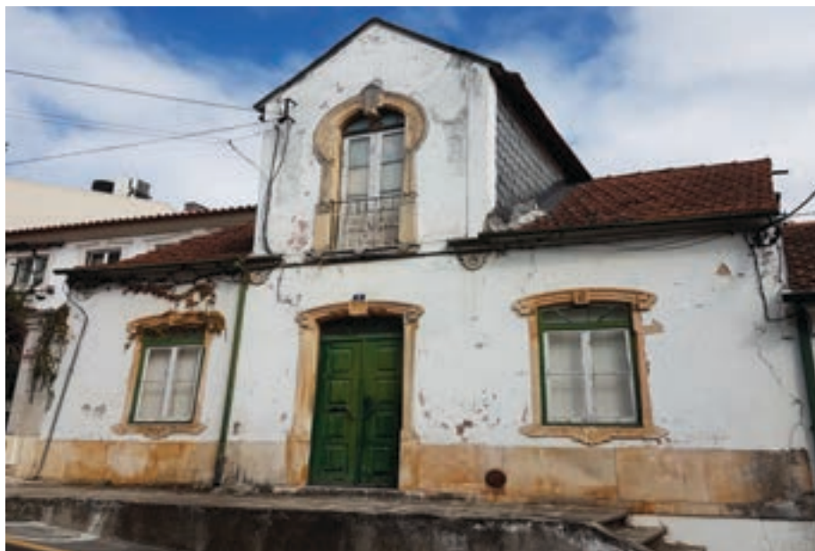
Ilustração 41 - Fachada Principal de uma moradia do conjunto habitacional: Avenida Dr. José Jardim (Ilustração nossa, 2017)
