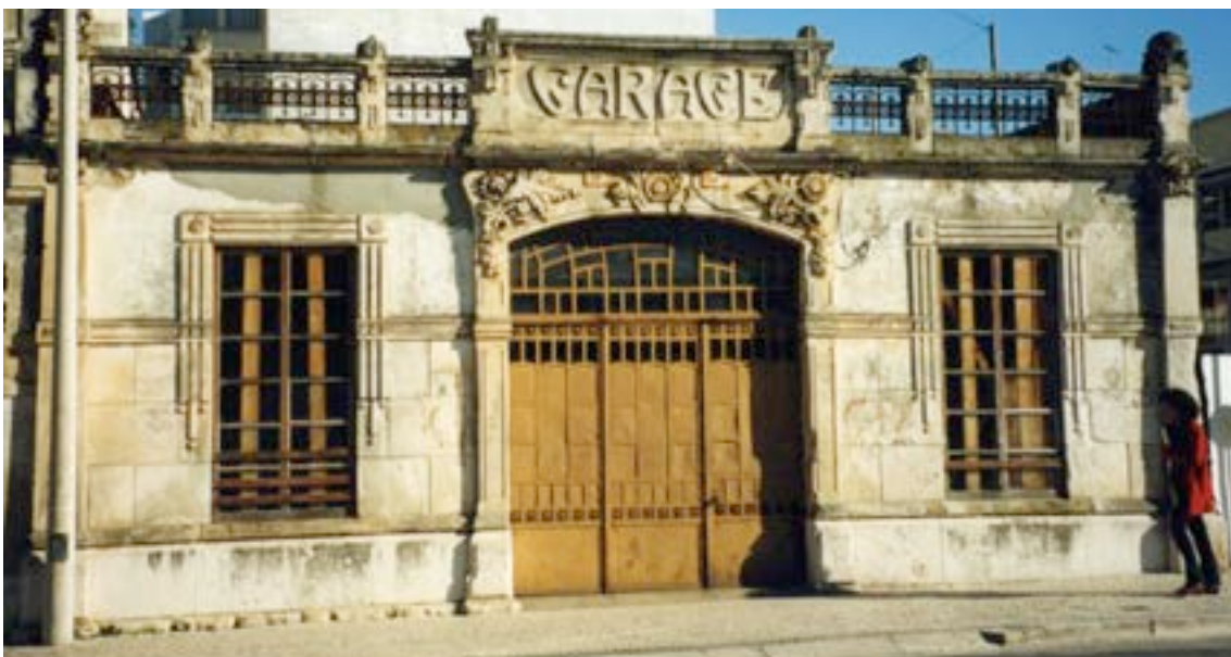
Ilustração 44 - Edifício Garage – Fachada Principal. (Arnaldo, 2009)
