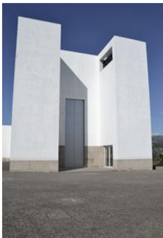
Ilustração 76 - Igreja Santa Maria, Fachada Sudoeste (ilustração nossa, 2017).
