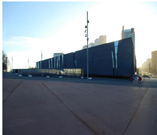
Ilustração 47 - Edifício Fórum. (Ilustração nossa, 2017).
