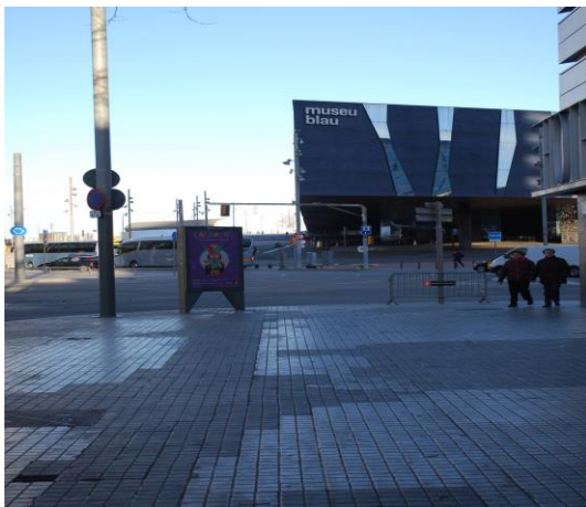
Ilustração 41 - Edifício Fórum. (Ilustração nossa, 2017)
