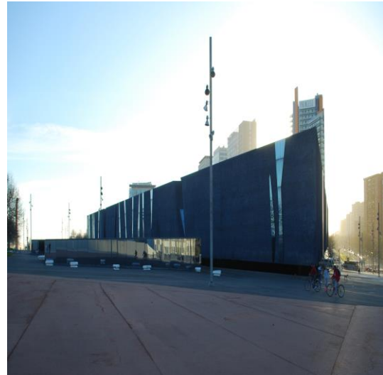
Ilustração 56 - Edifício Fórum. (Ilustração nossa, 2017).
