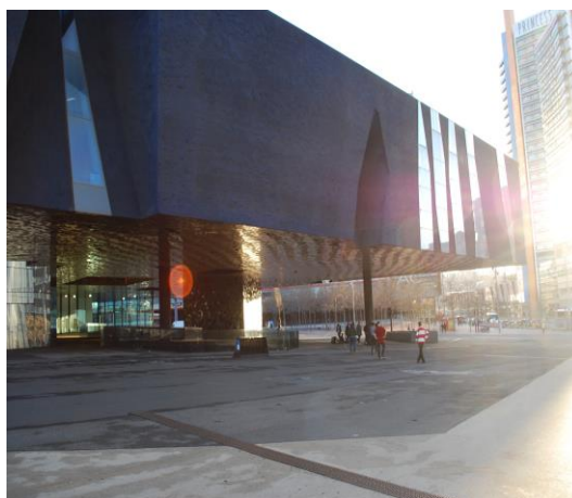
Ilustração 52 - Edifício Fórum. (Ilustração nossa, 2017)
