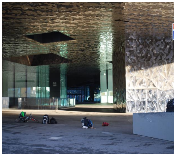
Ilustração 106 – Edifício Fórum. (Ilustração nossa, 2017).
