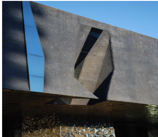
Ilustração 50 - Edifício Fórum. (Ilustração nossa, 2017)
