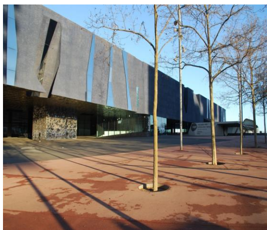
Ilustração 43 - Edifício Fórum. (Ilustração nossa, 2017)
