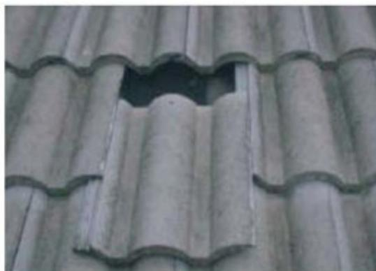
Ilustração 23 - Exemplo de patologia em cobertura inclinada por deslocamento das telhas (Ilustração nossa)
