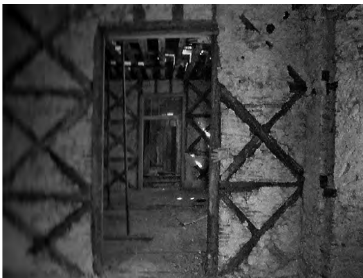
Ilustração 11 – “Interior de edifício Pombalino, em obras, no qual é visível a ‘gaiola’ de madeira”. (Appleton, 2005, p.11)
