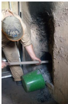
Fig.47 - Limpeza da fornalha
