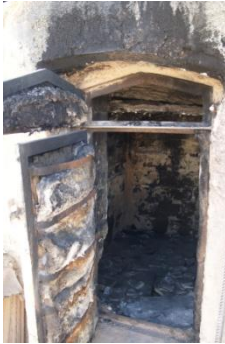
Fig.87 - Forno com mecanismo de encerramento através de porta dispensando a construção de parede
