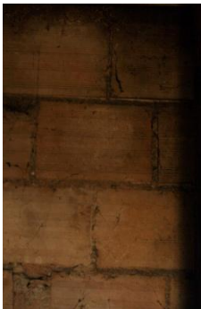
Fig.80 - Paredes de tijolo onde ainda se observam as marcas das bolas de barro que foram lá coladas para secar
