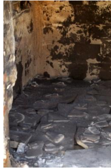
Fig.88 - Pavimento do forno revestido por pedaços de cerâmica refractária para compensar deformações do forno e evitar desequilíbrio da louça
