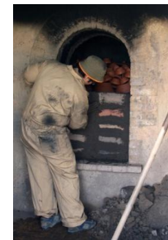
Fig.50 - Levantamento do muro de tijolos unidos por barro
