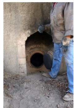
Fig.86 - Fornalha com mecanismo de fecho através de porta dispensando a utilização do caçoilo
