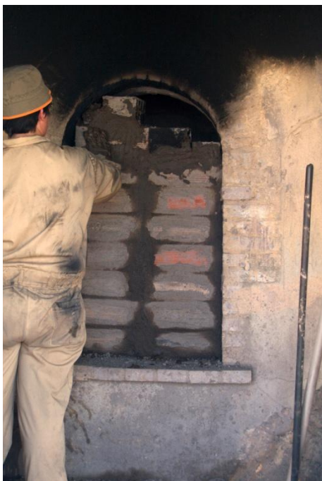
Fig.59 Encerramento do forno
