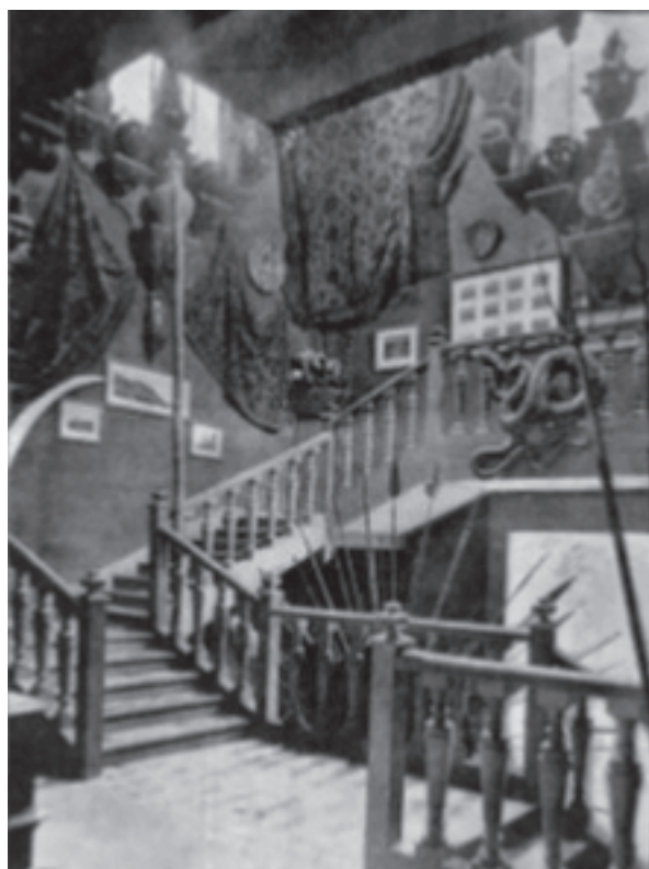
Fig.12 - Escadaria de acesso à Sala de Conservas
