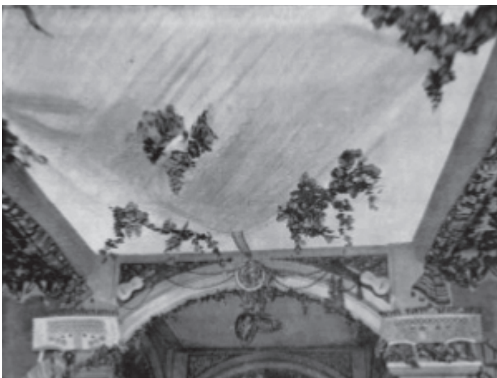
Fig.5 - Tecto Central da Sala de Entrada
