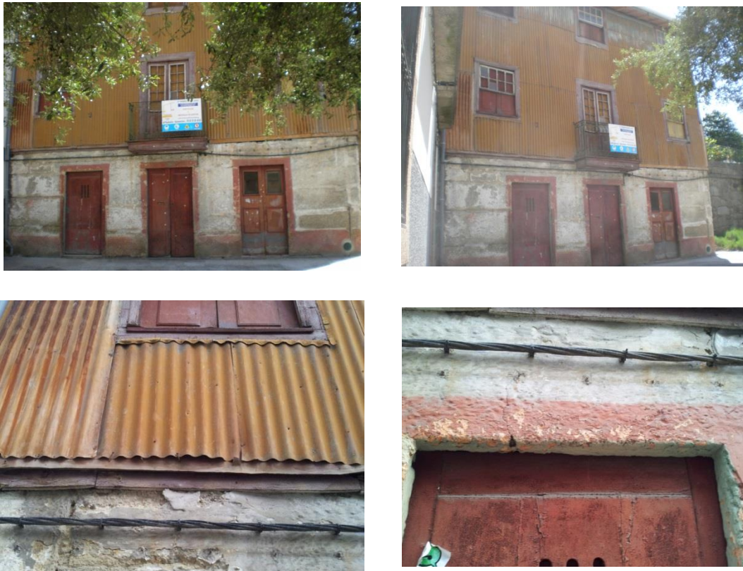
Figura 34 – Aspeto do revestimento exterior (Própria, 2013)
